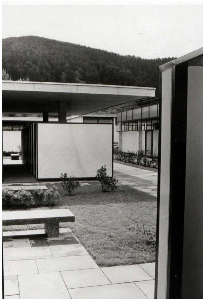
Der Kabinentrakt umfasst 160 Saisonkabinen und ist durch das abgehobene Dach gut durchlüftet.
