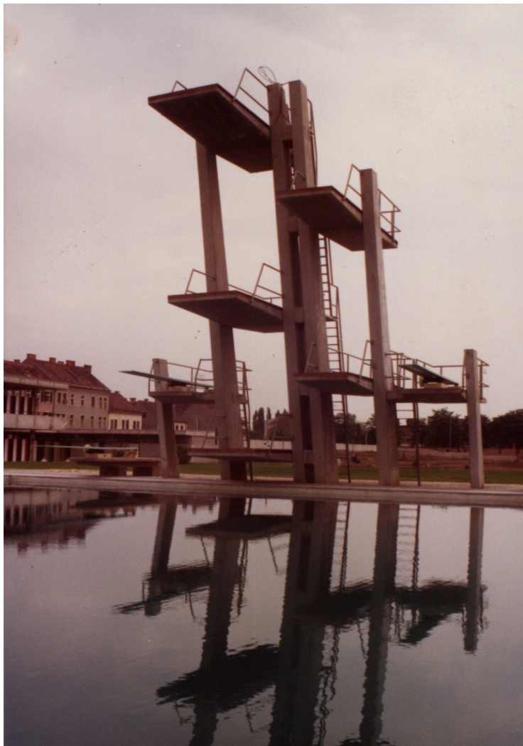
Der Sprungturm mit den Plattformen auf 1, 3, 5, 7,5 und 10 Meter und den vier Sprungbrettern auf 1 und 3-Meter war auf dem aktuellsten Stand der internationalen Sprungturmnormen.
