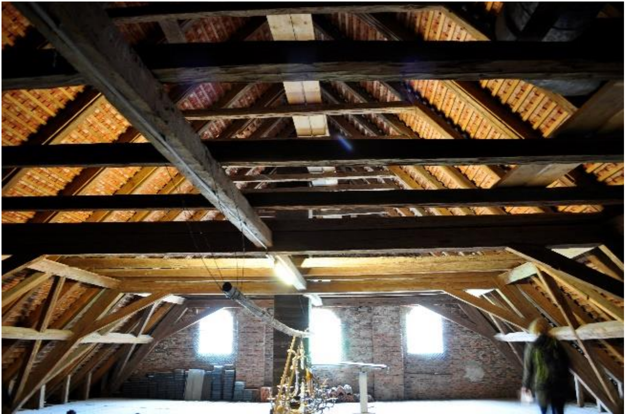
Abbildung 6-7 Hauptdach: Dachstuhl über dem Haupttrakt des Wirtschaftsgebäudes
