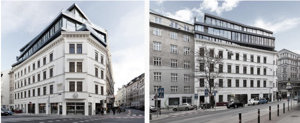
Abbildung 2-20 Bestandsbeispiel Aufstockung in Wien [9]
