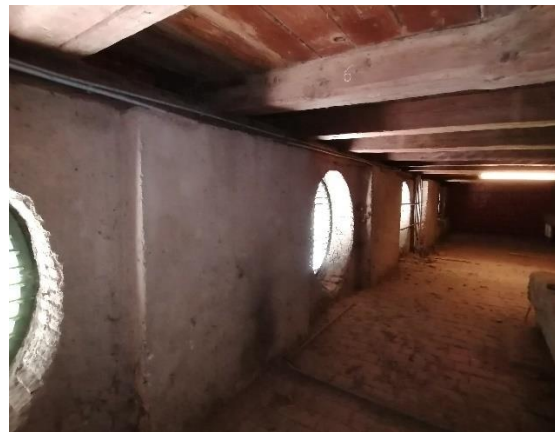
Abbildung 6-10 Außenwand Längsseite mit Rundfenstern (bildet das Auflager für Bundträme)
