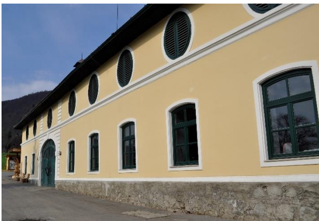
Abbildung 6-10 Außenwand Längsseite mit Rundfenstern (bildet das Auflager für Bundträme)
