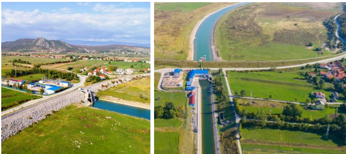
Abb. 53: Sanierung des Pumpspeicherkraftwerks Buško blato welches Anfang der 70er Jahre erbaut wurde. [Q53]
