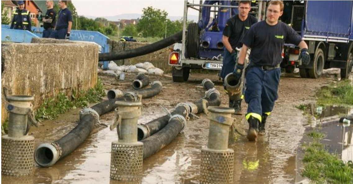
Abb. 59: Das Technische Hilfswerk beim Aufbau der Hochleistungspumpenanlage [Q59]
