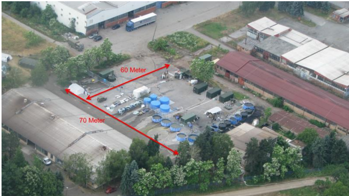
Abb. 64: Areal der gesamten Wasseraufbereitungsanlage [Q64]
