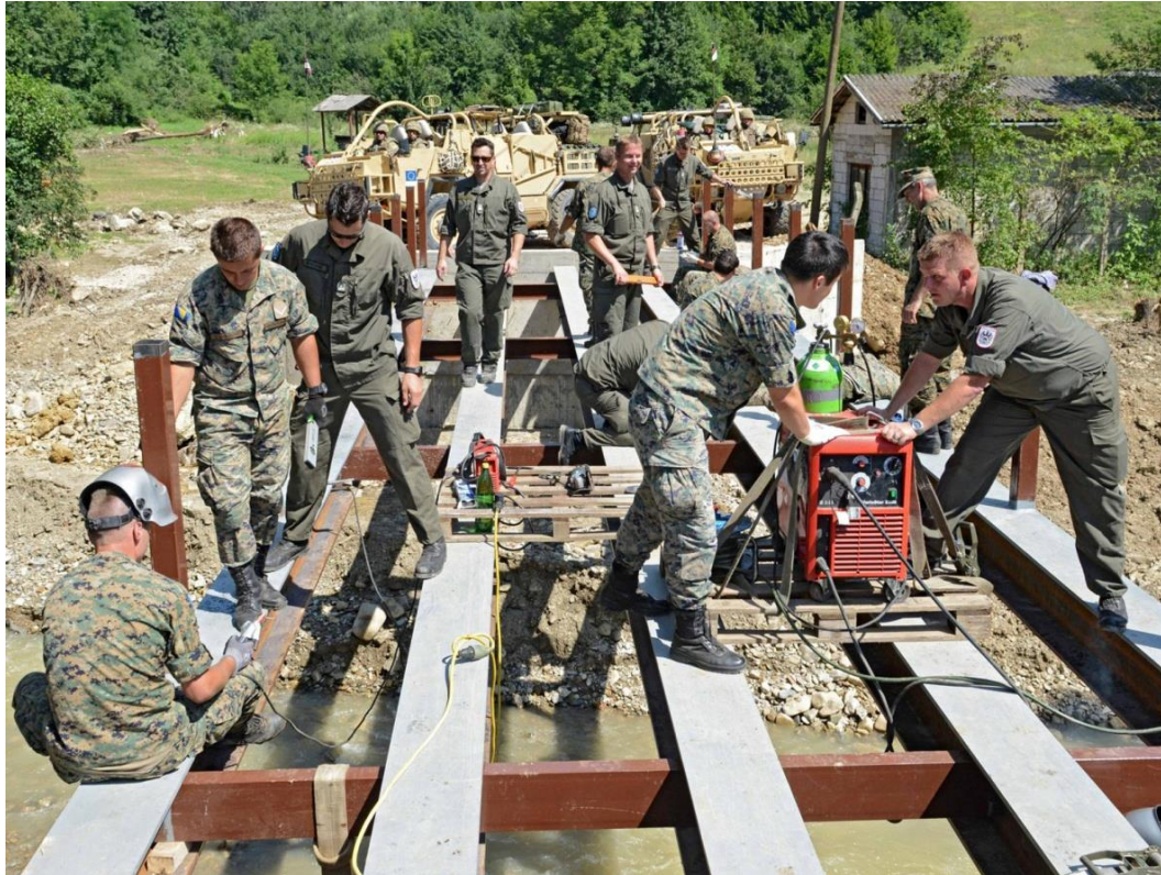
Abb. 67: Bau einer Behelfsbrücke [Q67]
