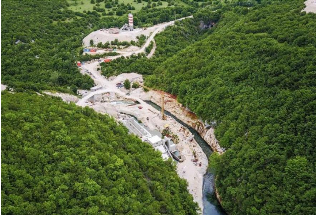
Abb. 16: Eines von drei in Bau befindlichen Wasserkraftwerken an der Sana in Bosnien, Auftraggeber: KELAG [Q16]
