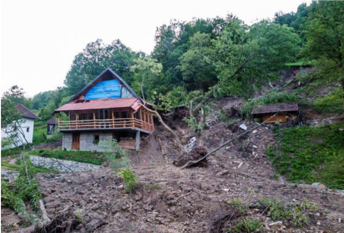
Abb. 49: Durch Erdbeben blockierte Straße M17 südlich von Doboj [Q49]
