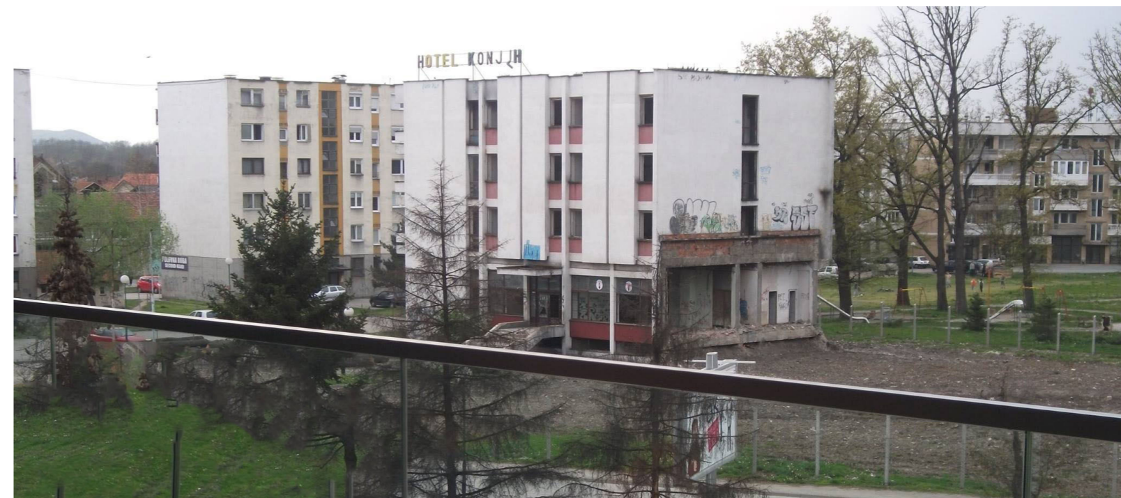
Abb. 20 Der Baukörper der noch immer als Bestand steht, der zweite Teil wurde abgerissen 2015
