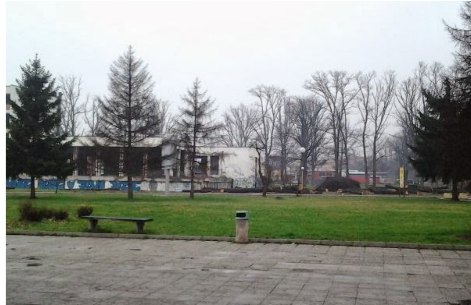
Abb. 19 Das zerstörte Hotel Konjuh 2009
