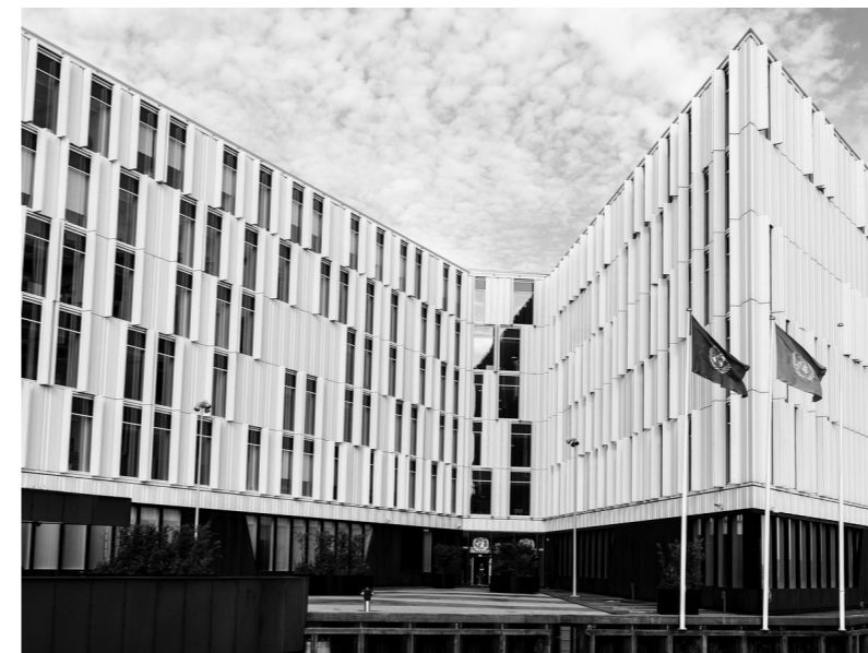
Abb. 37 UN Gebäude Kopenhagen, Fassadenelemente
