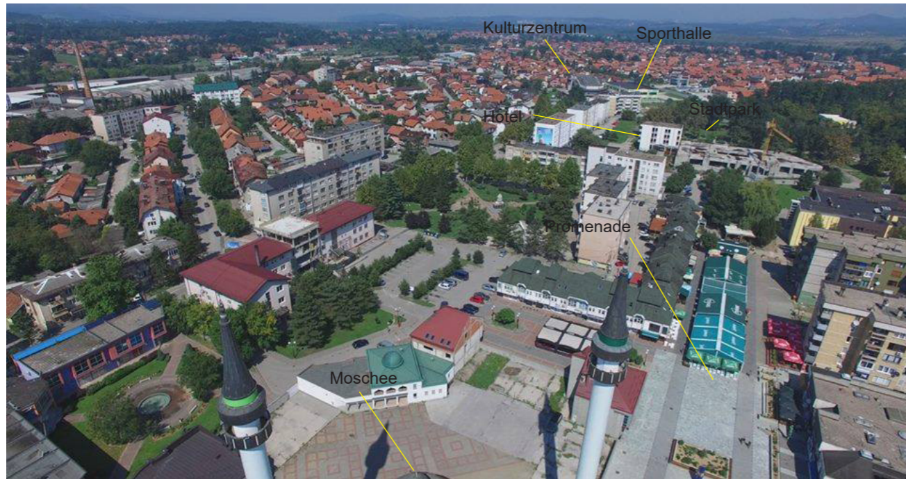
Abb. 46 Planungsgebiet, Blick nach Norden
