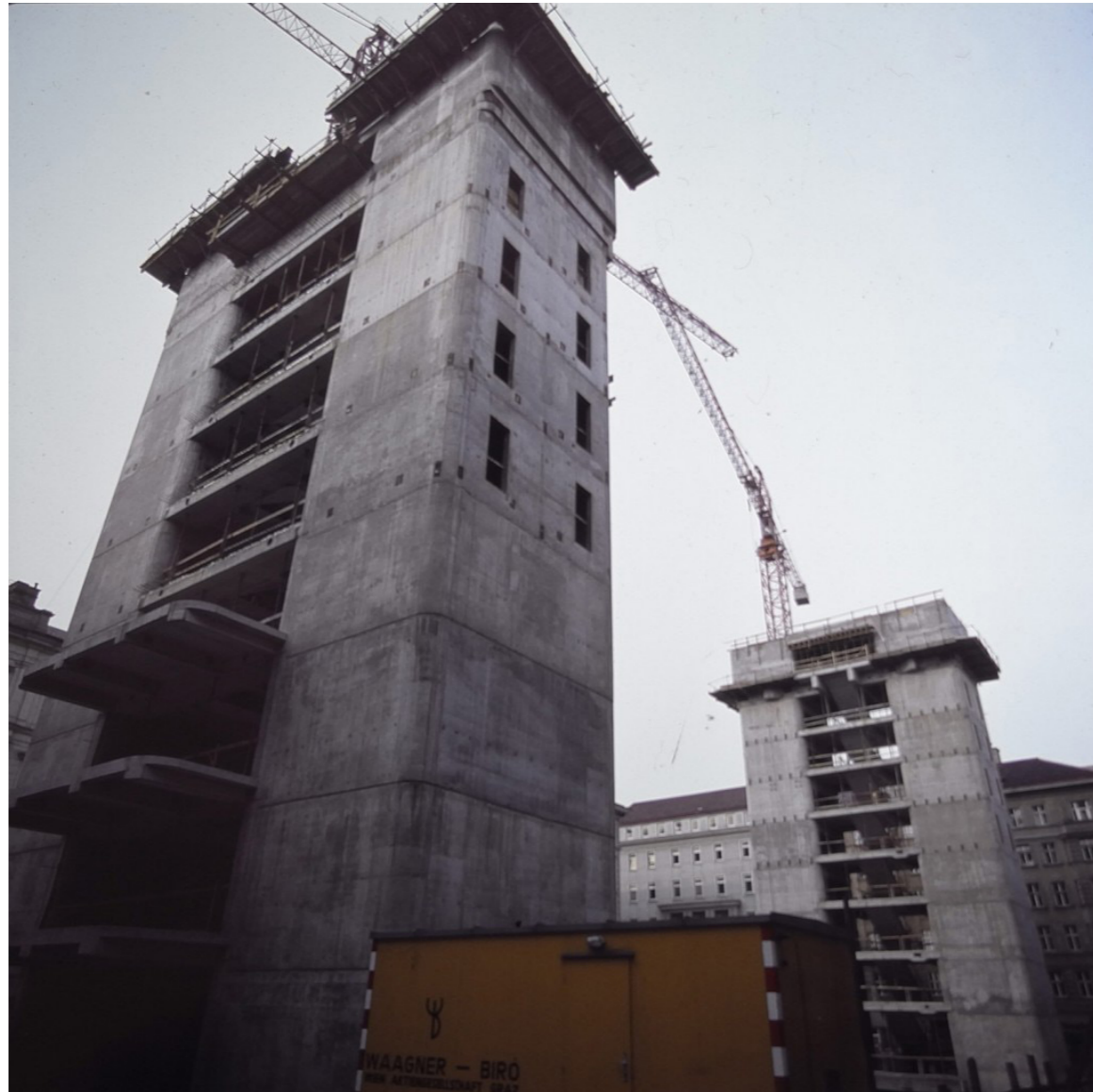
Abb. 29 Juridicum während der Bauarbeiten, Wien
