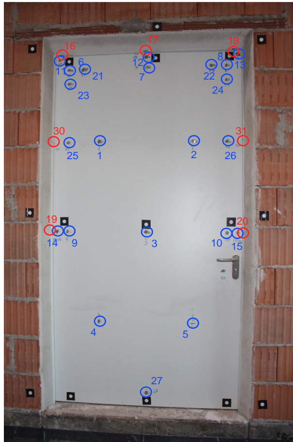
Abbildung 3-5: Temperaturmessstellen Brandschutztür & Zarge
