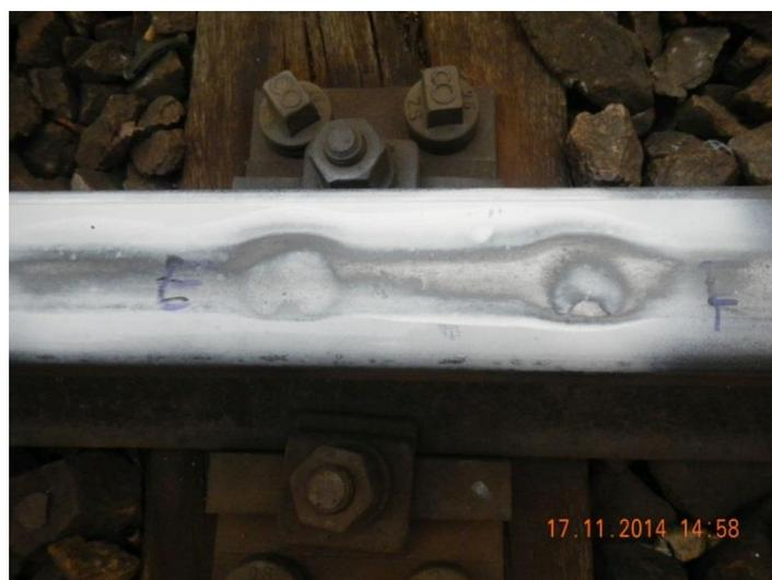
Abbildung 4: Variation des Fahrspiegels, verursacht durch einen Squat. Der Fahrspiegel wurde mit Hilfe von weißer Sprühfarbe, welche durch die Räder eines Zuges teilweise entfernt wurde, sichtbar gemacht.
