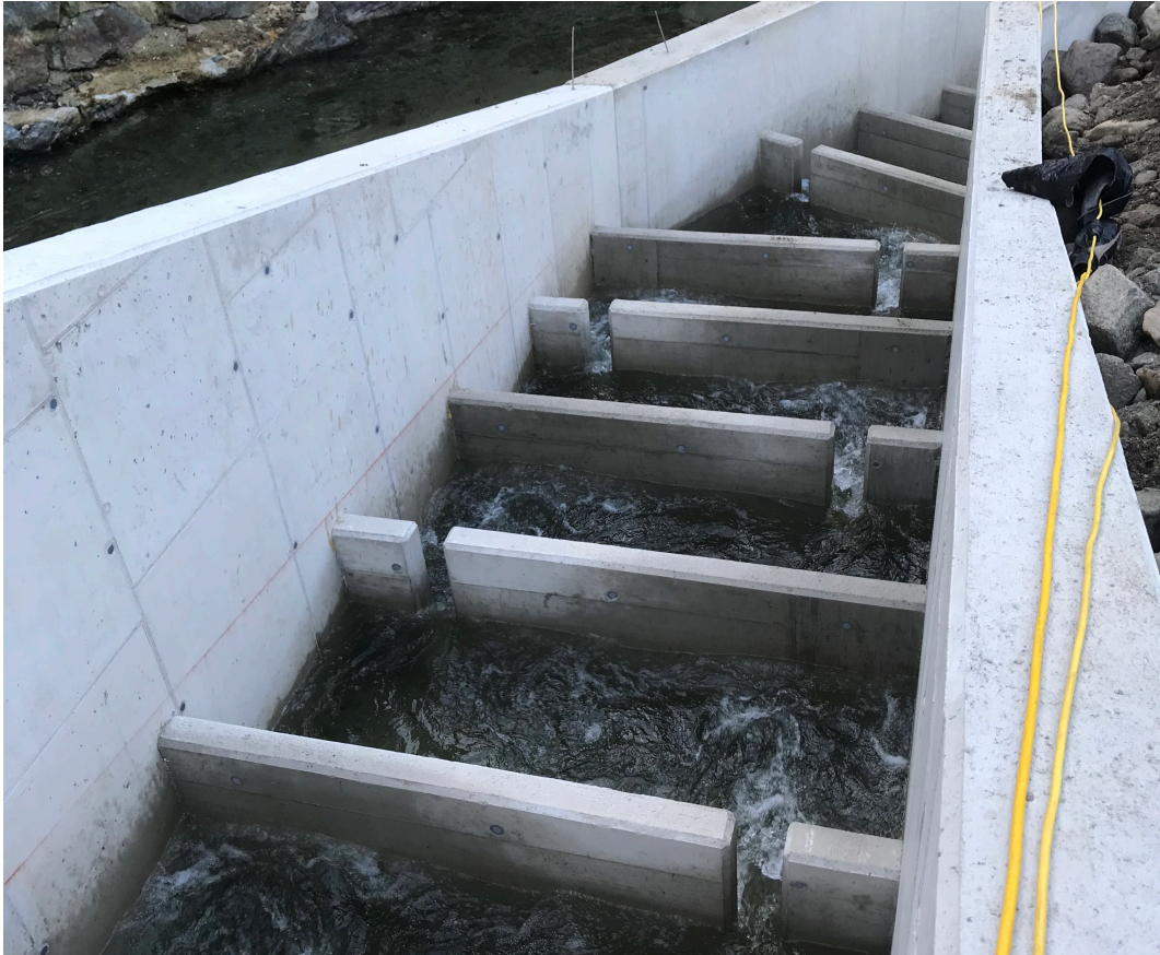
Abbildung 8: TB, Betongerinne an der Feistritz (eigene Aufnahme)
