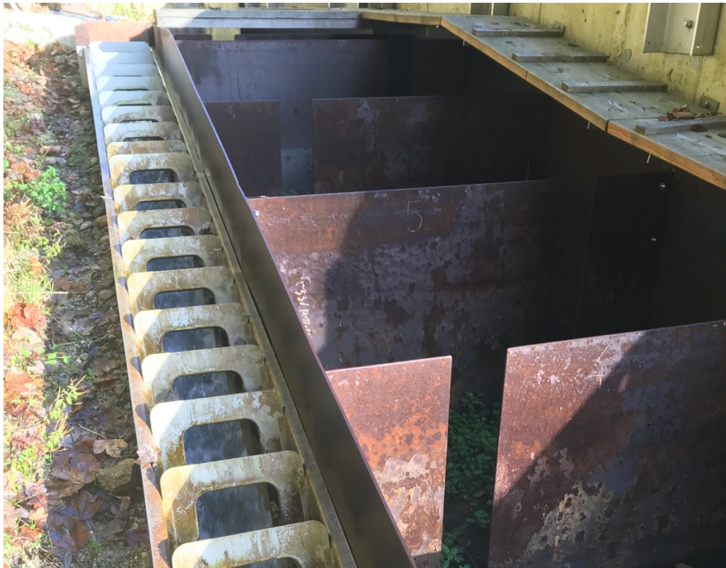
Abbildung 10: Modifizierter Denilpass (links) neben einem TB (rechts) am Hirschbach/Ratten (eigene Aufnahme)
