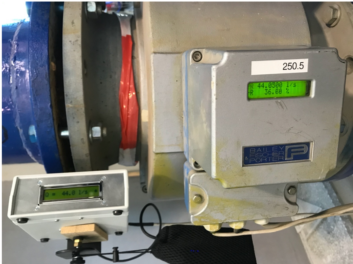
Abbildung 34: Protokollschreiber (links) an induktivem Durchflusszähler
