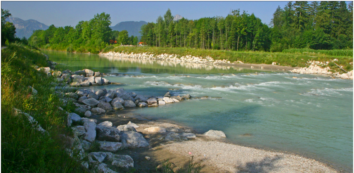
Abbildung 4: Ausführungsbeispiel Aufgelöste Sohlrampe (AG-FAH 2011)
