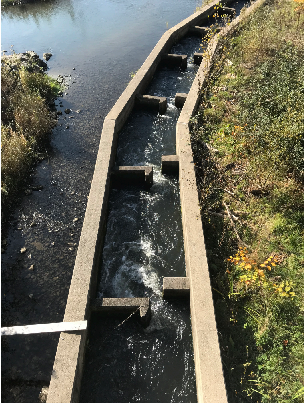
Abbildung 6: Vertical Slot Schlitzpass an der Mur (eigene Aufnahme)
