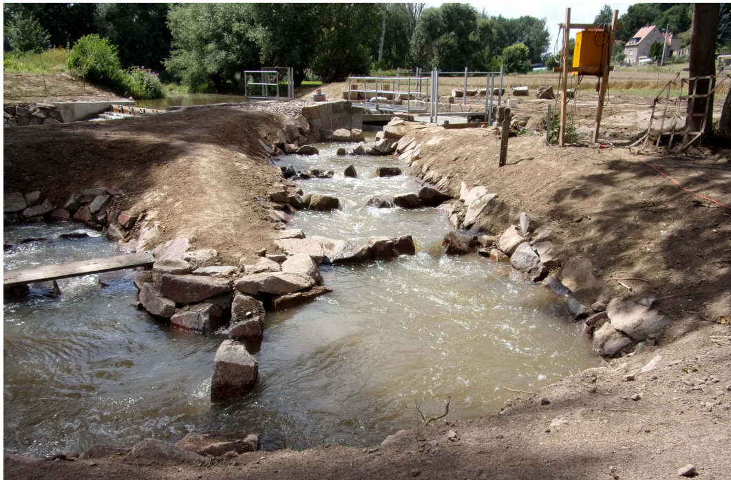
Abbildung 5: Naturnaher Beckenpass am Ketzerbach/DE (Handrick 2016)
