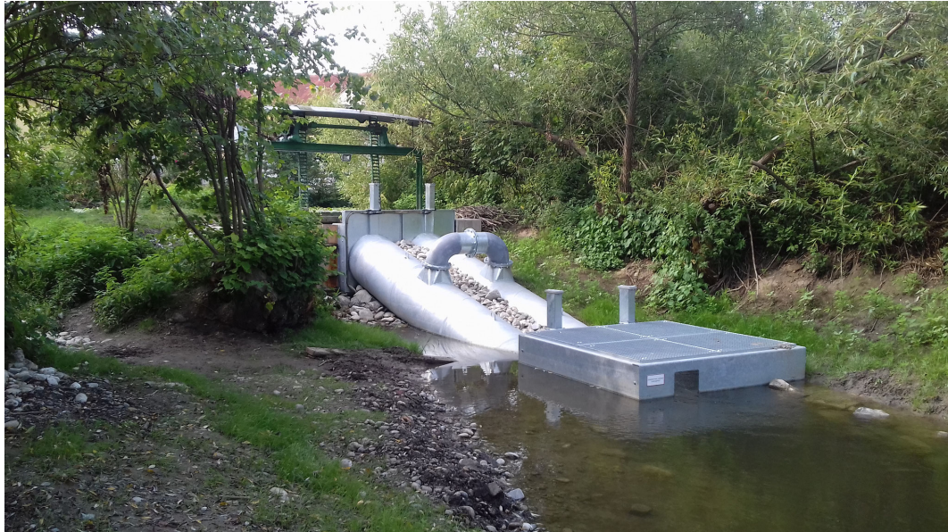
Abbildung 14: Ausführung ‚FISHCON‘-Schleuse (FISHCON GmbH 2019)
