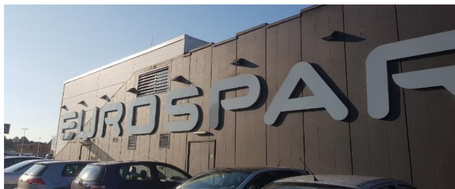
Abbildung 2.65: Die Fassade in der Nord-Ostseite
