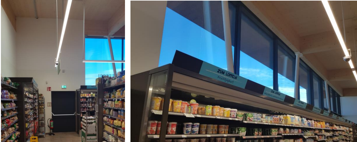
Abbildung 2.38: Links: Wandscheibe in der Ostseite; rechts: drei eingespannte Stahlstützen mit \Phi 14\text{cm} in die Ostseite des Einkaufsmarktes
