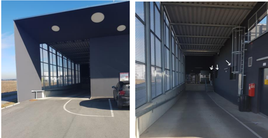
Abbildung 2.32: Links: westlicher Lieferanteneingang; rechts: drei „Fenster“ an der Nordseite
