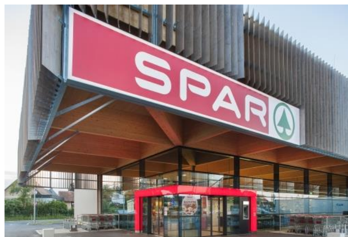
Abbildung 2.3: Ansicht Eingangssituation; Leimbinder und Holzlamellen
