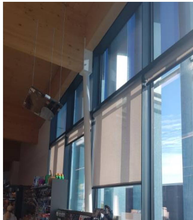
Abbildung 2.37: links und rechts: Südseite - eingespannte Stahlstütze mit \Phi 14\text{cm} hinter der Glasfassade
