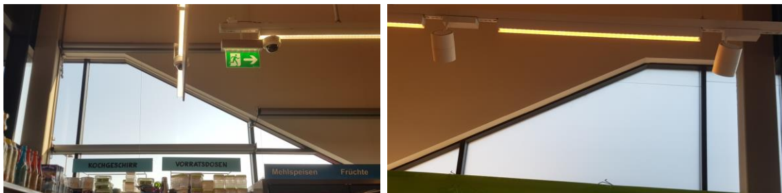
Abbildung 2.66: Oben: transparente Fenster mit dem Textilrollo in der Nord-West Seite; links: transparente Fenster mit dem Textilrollo ebenfalls im unteren Bereich in der Nord-Ost Seite; rechts: transparente Fenster ohne dem Textilrollo in der West- Süd Seite
