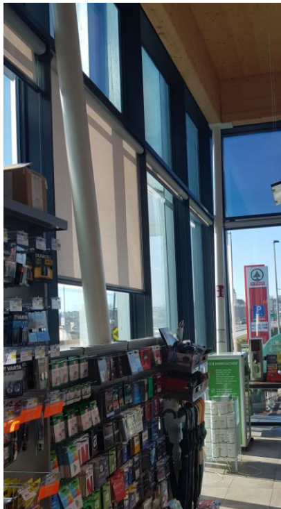
Abbildung 2.37: links und rechts: Südseite - eingespannte Stahlstütze mit \Phi 14\text{cm} hinter der Glasfassade
