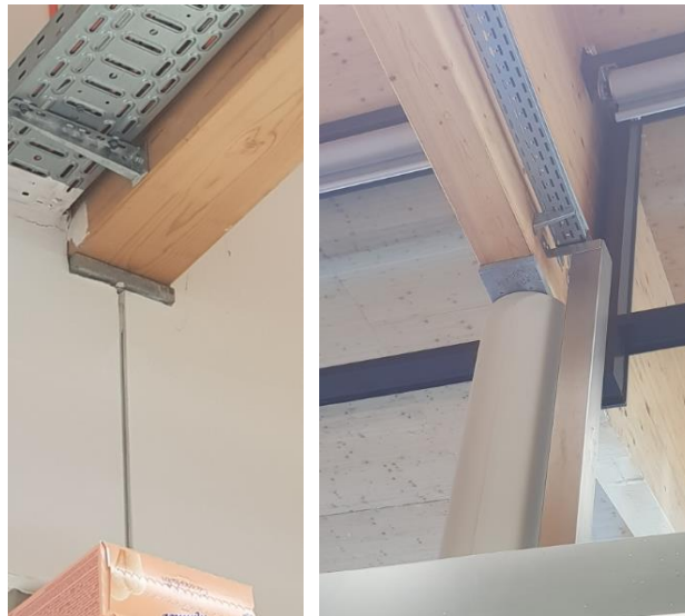
Abbildung 2.73: Holzleimbinder 166/20 in Richtung der Lagerbereich; rechts: die Leimbinder liegen auf die runde Betonstützen \Phi 30 cm in der Nord-West Seite
