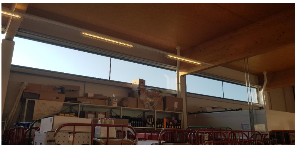
Abbildung 2.67: das Fenster in Ost-Südseite, Lagerbereich
