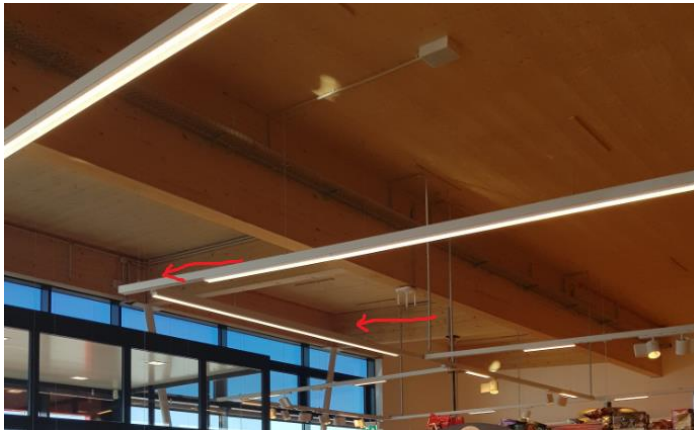
Abbildung 2.36: Links: Träger in Längsrichtung mit einer Neigung von 5,5°; rechts: die Stahlstützen in der Verbindung mit dem primäre Tragsystem
