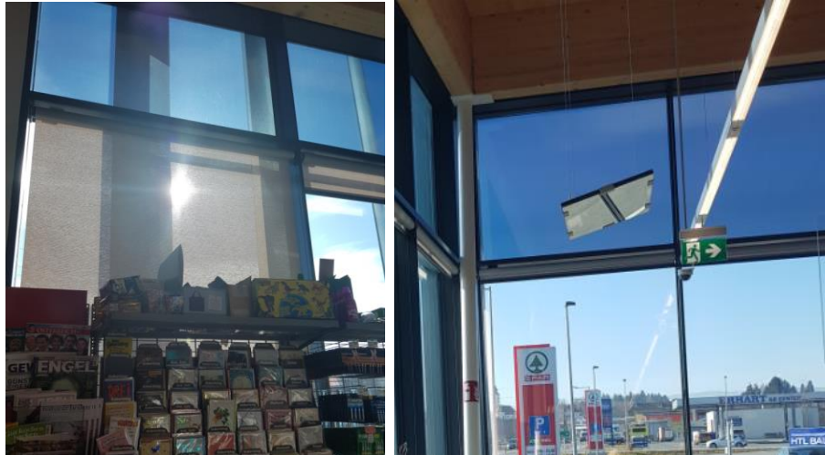
Abbildung 2.33: links: Südseite des Einkaufsmarktes, oben Schutzfolie, unten Textilrollo; rechts: Westseite des Einkaufsmarktes, oben Schutzfolie unten Textilrollo.
