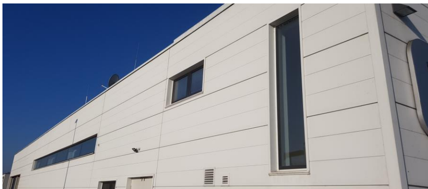
Abbildung 2.64: Fassade in Ost-Südseite
