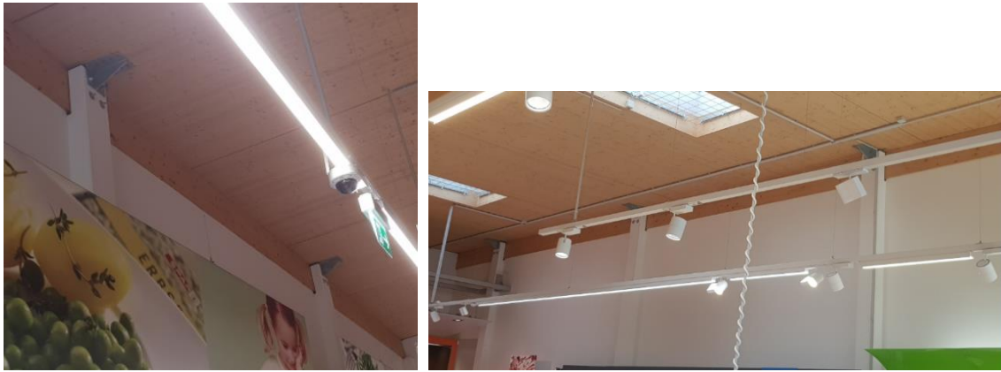
Abbildung 2.70: Links/rechts: Das primäre Tragsystem in der Hauptspannrichtung des Einkaufsmarktes
