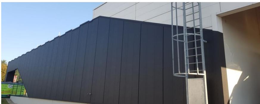
Abbildung 2.63: PREFA Fassade in West-Südseite
