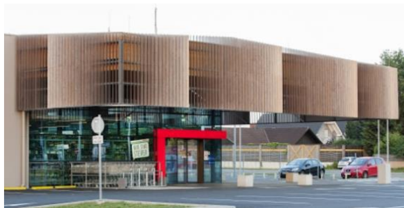
Abbildung 2.5: links oben: West- und Südseite des Einganges; rechts unten Westseite des Einganges
