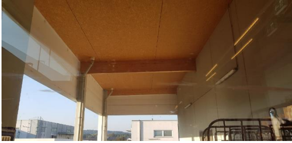
Abbildung 2.74: Links: Holzleimbinder 166/20 cm entlang das Vordach; rechts: Holzleimbinder 100/18 cm in Querrichtung, Aussicht vom Lagerbereich
