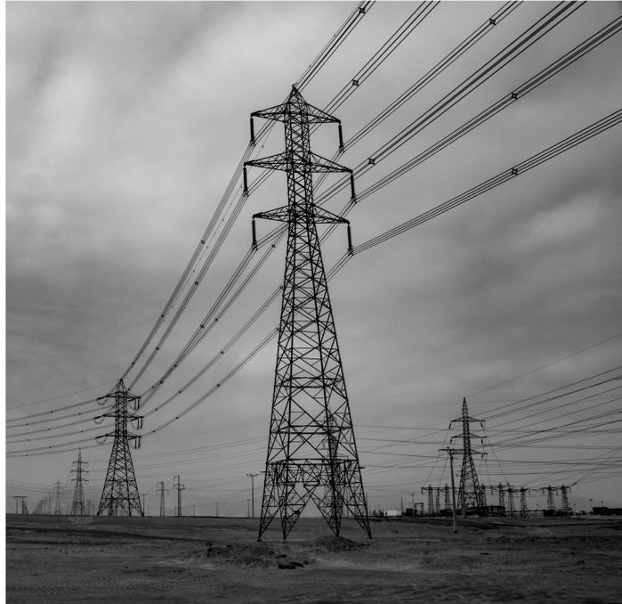
Bild 3.3: 500-kV-Freileitung mit Stahlgittermasten und Bündelleiter [Wik18]
