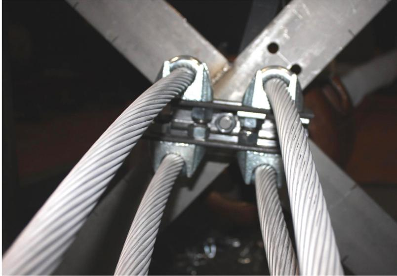
Bild 8.16: Spezial-Klemmvorrichtung für Vierleiterbündel zur Erzielung eines Teilleiterabstands von  $a = 100 \text{ mm}$
