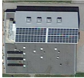
Abbildung 3.1: Photovoltaikanlage auf dem Dach des Veranstaltungszentrums [59]
