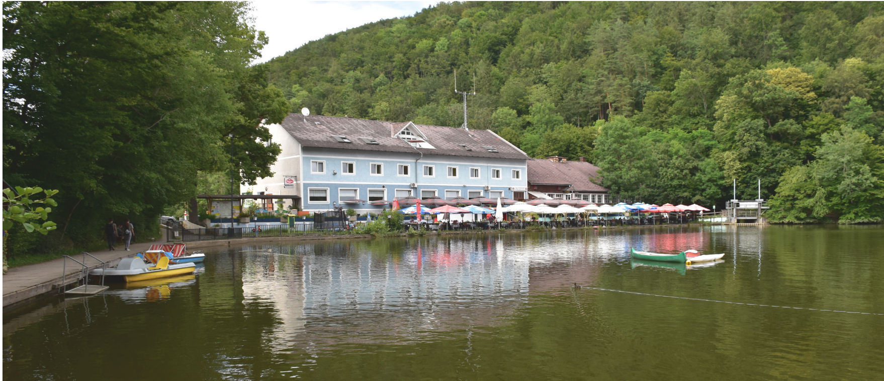
Abb. 50 Bestandsgebäude, Blick vom See.
