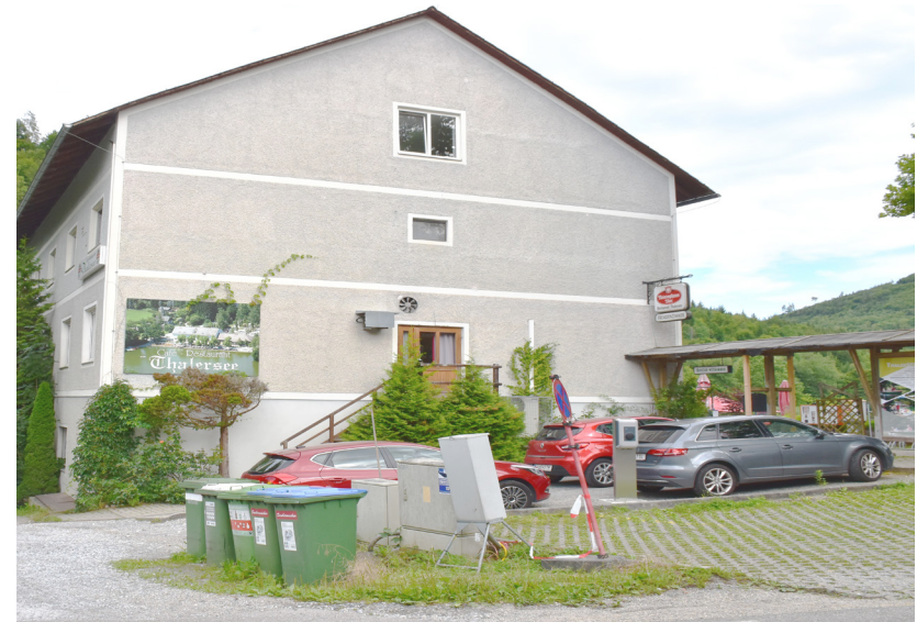
Abb. 52 Bestandsgebäude, Blick von der Straße..
