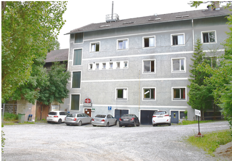
Abb. 51 Bestandsgebäude, Blick vom Parkplatz.
