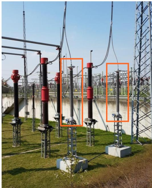
Bild 2.8.: Installierte 400-kV-RC-Teiler (orange) im Umspannwerk auf mobilen Untergestellen ([10]-bearbeitet)
