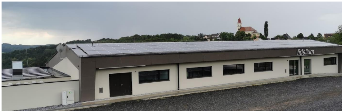
Bild 7.1: Veranstaltungshalle „fidelium“ in Eichkögl mit PV-Anlage am Dach
