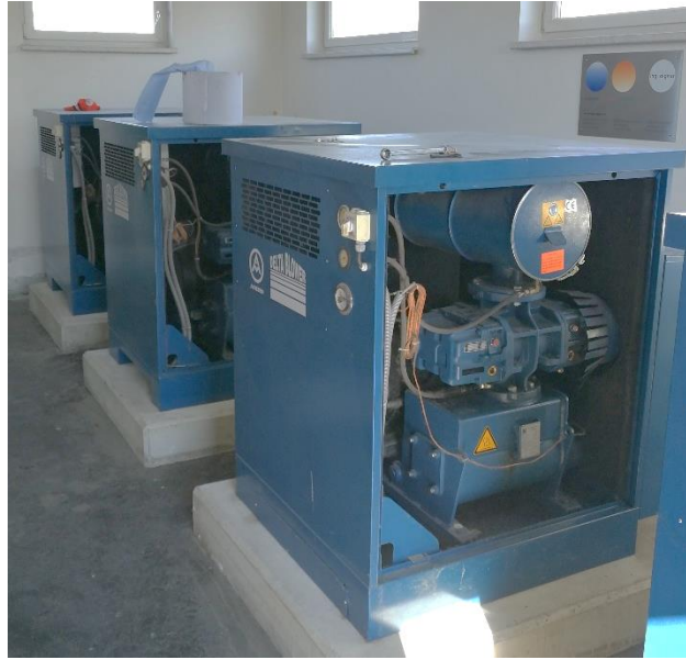
Bild 6.7: Drehkolbengebläse im Gerätehaus
