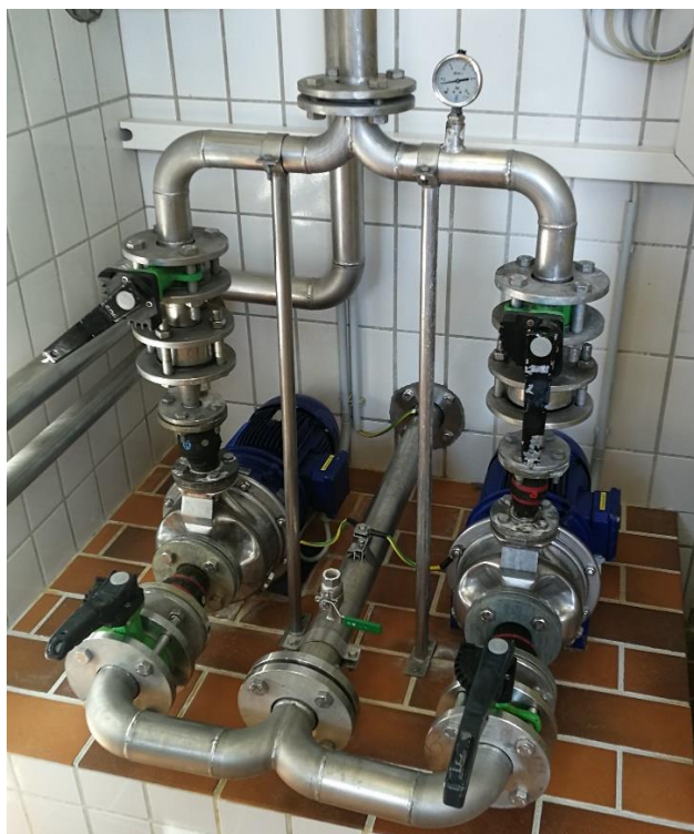
Bild 5.3: Rohwasserpumpen Mitterfladnitz
