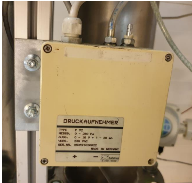
Abbildung 4-21: Differenzdrucksensor P92 zur Messung des luftseitigen Druckabfalls am ExHX
