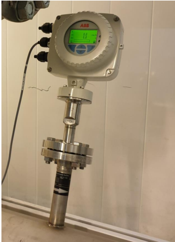
Abbildung 4-22: SensyMaster FMT des äußeren Luftkanals
