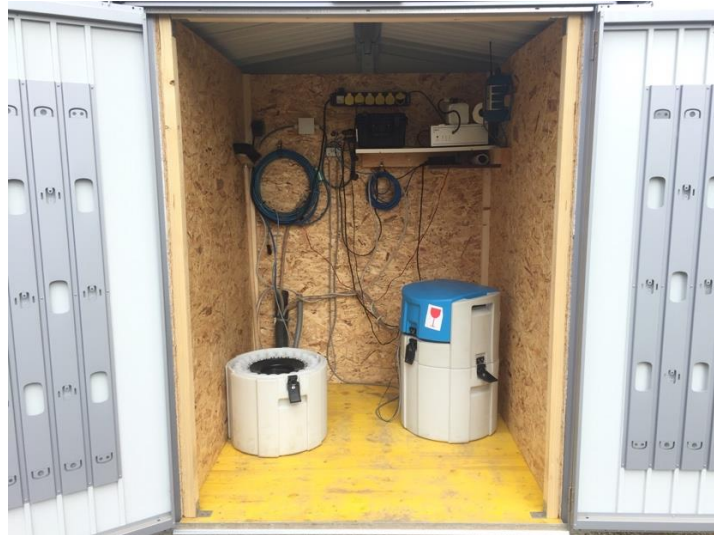
Abbildung 2-21: Errichtete Messhütte mit den Probenahmegeräten an der MS-Niederschlagswasser
