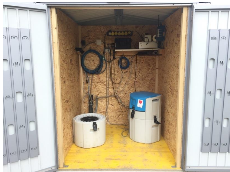
Abbildung 4: Errichtete Messhütte mit den Probenahmegeräten an der MS-Niederschlagswasser
