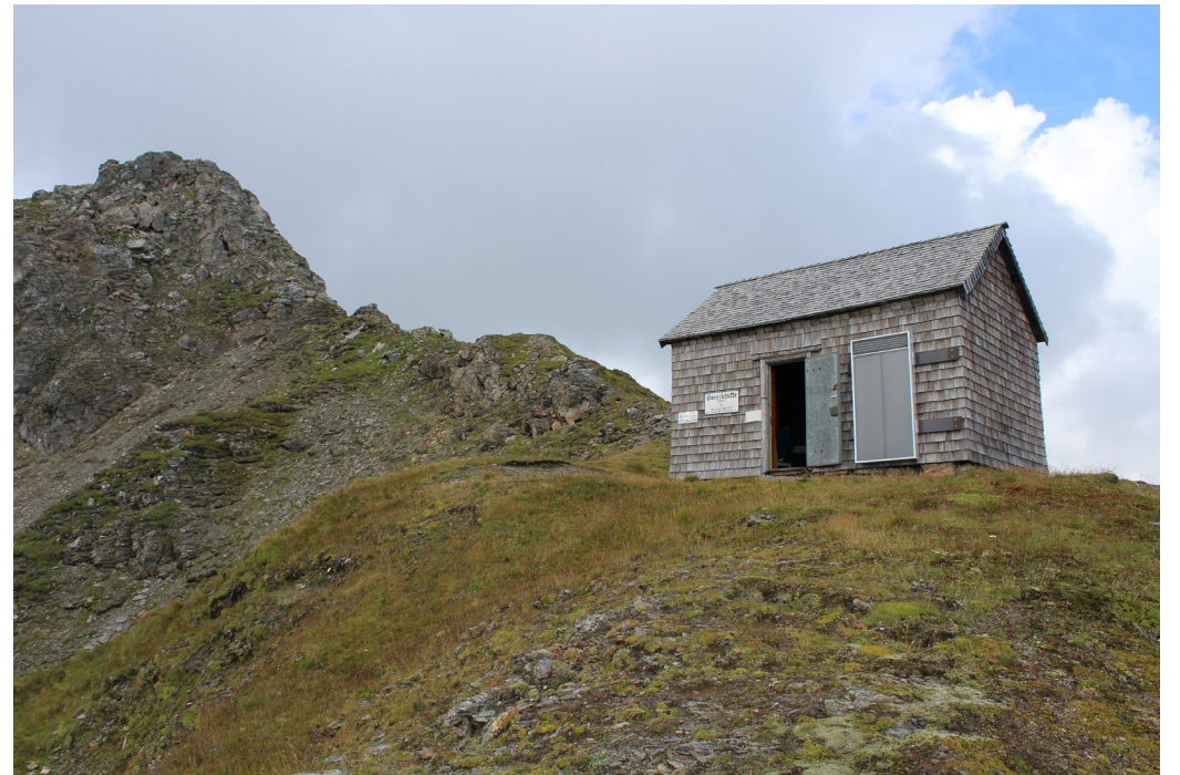
Abb.67: Bestandsobjekt Süd Ansicht
