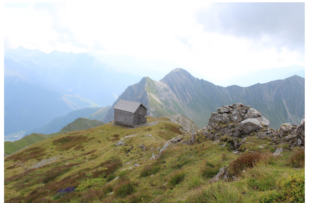
Abb.65:Bestandsobjekt Nord Ansicht
