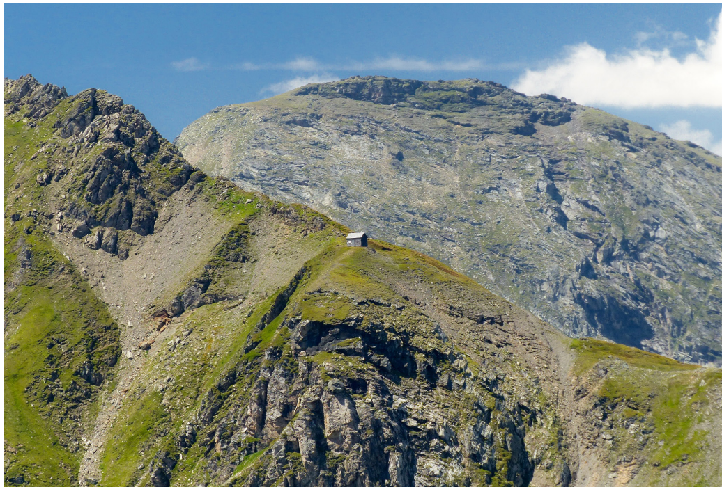
Abb.66: Bestandsobjekt Süd Ansicht Fernblick
