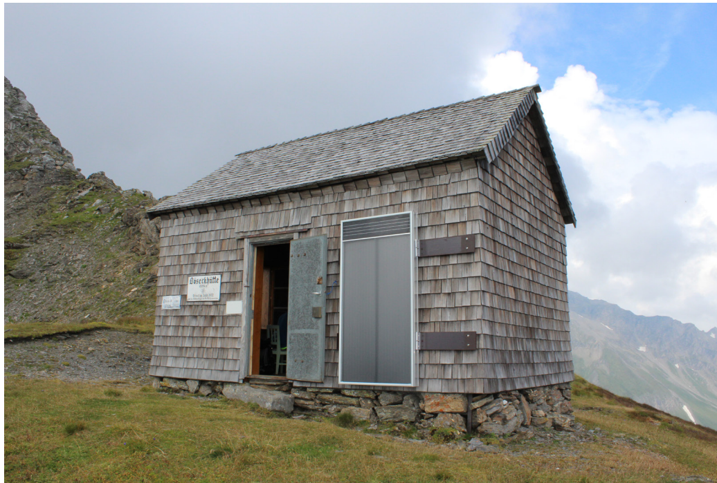
Abb.70: Bestandsobjekt Ansicht Solarlüftungsanlage
