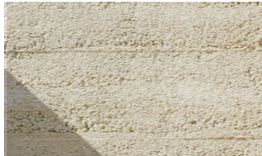
Abb. 47: Stampfbetonwand
