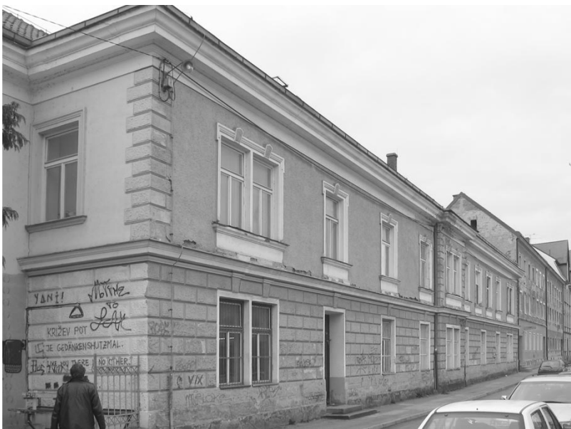
Abbildung 4: Altes Foto von Upravna zgradba
