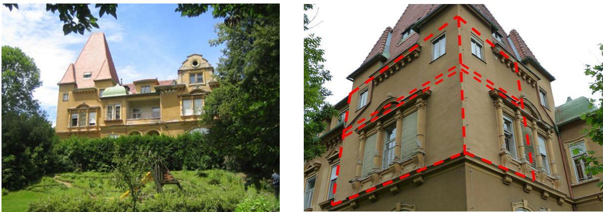
Bild 9 Links die Südost-Ansicht des Kindergartens Schönbrunn-gasse 30; rechts der Südturm mit den übereinanderliegenden Versuchsräumen im Obergeschoß und Dachgeschoß
