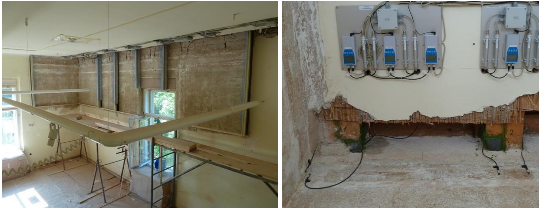
Bild 16 Links Ansicht der Messfelder vor Aufbringung der Dämmsysteme; rechts Zellulose-Messfeld in der Gebäudeecke, gesehen vom unteren Geschoß mit schon abgedichteten Holzfeuchtesensoren; an der Decke Montageplatten mit der Messelektronik
