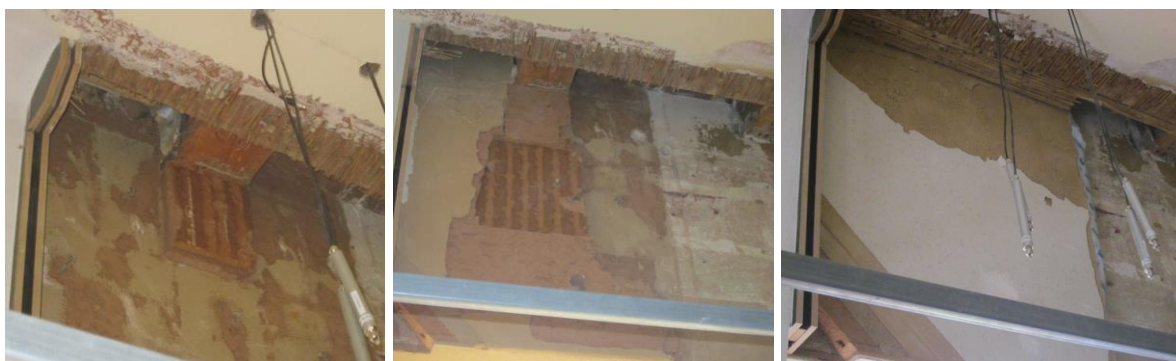
Bild 30 Abbruch Holzweichfaserplatte
