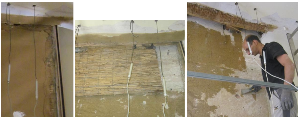
Bild 31 Abbruch Schilfplatten
