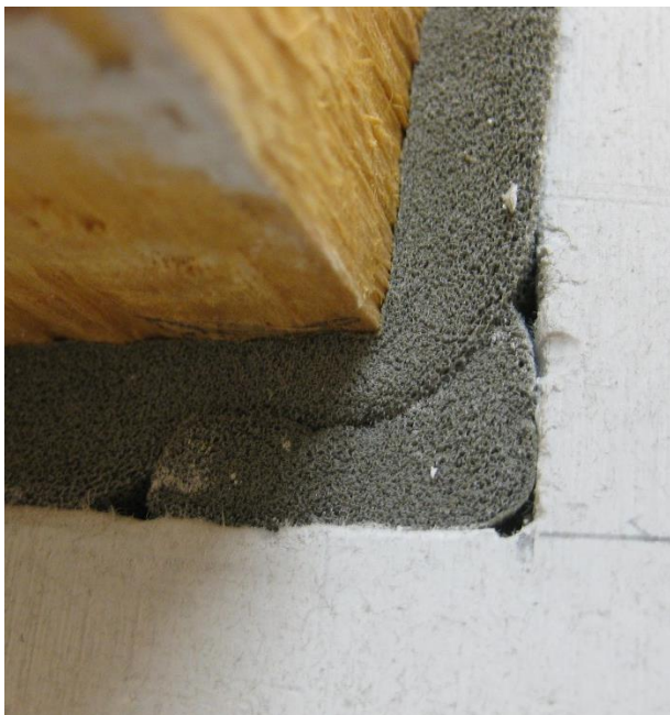
Bild 6 Ein Balkenaufleger mit vorkomprimiertem Dichtungsband, das in der Ecke zusätzlich abgedichtet wurde
