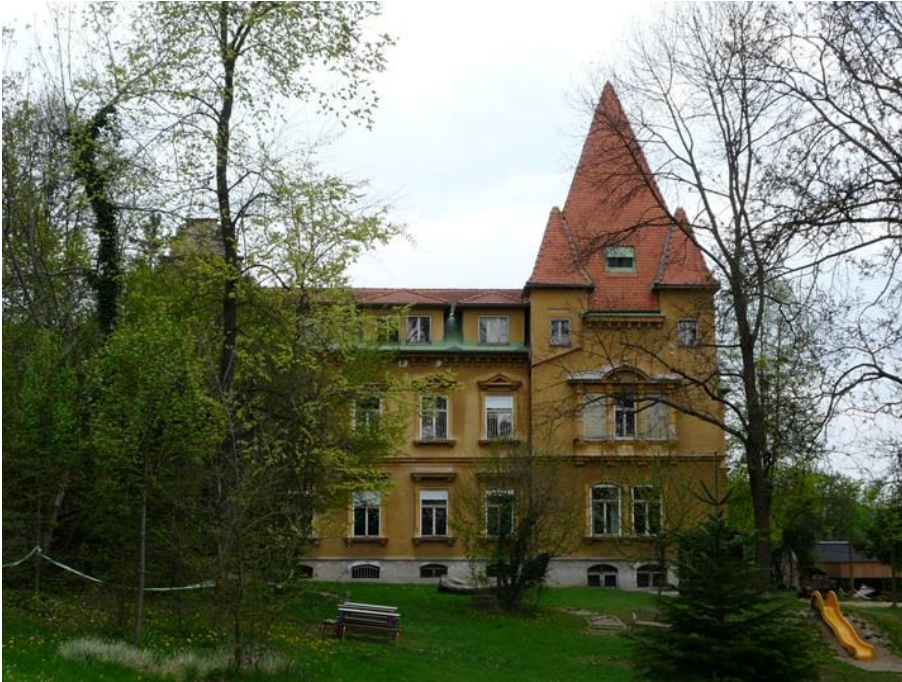
Bild 110 Ansicht der nach Südwestsüd ausgerichteten Fassade am 17. April 2011;
