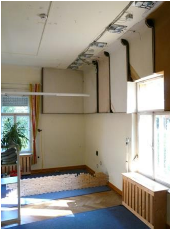
Bild 21 Gesamtansicht der fünf Dämmsysteme im Obergeschoß nach Abschluss der Arbeiten; von links: Zellulose, Perliteplatte, Wärmedämmputz, Holzweichfaserplatten und Schilfmatten
