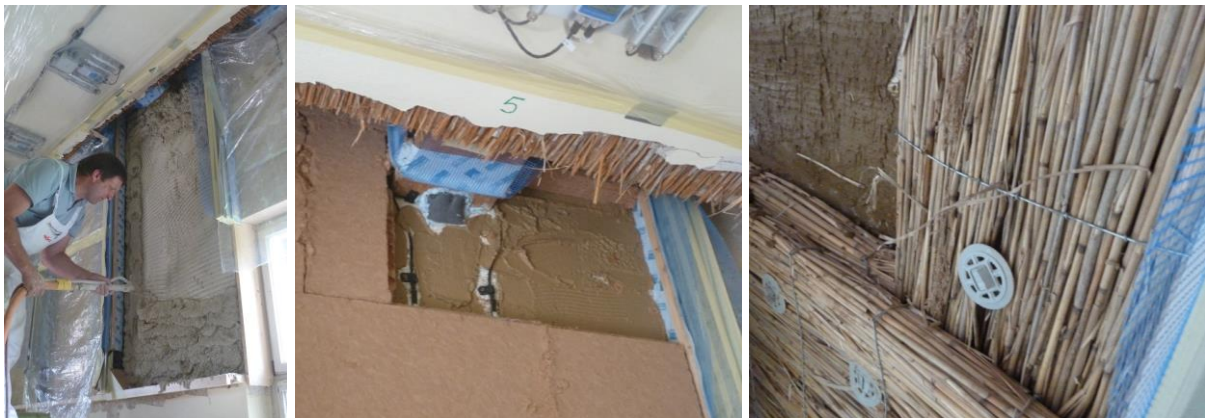
Bild 20 Links Einbringen der ersten Lage Wärmedämmputz; in der Mitte Aufkleben der Holzweichfaserplatten auf Lehmputz (am Balkenkopf eine „Kleband-“Manschette für den luftdichten Anschluss); rechts zwei übereinanderliegende, 50 mm dicke Schilfmatten in Lehmputz
