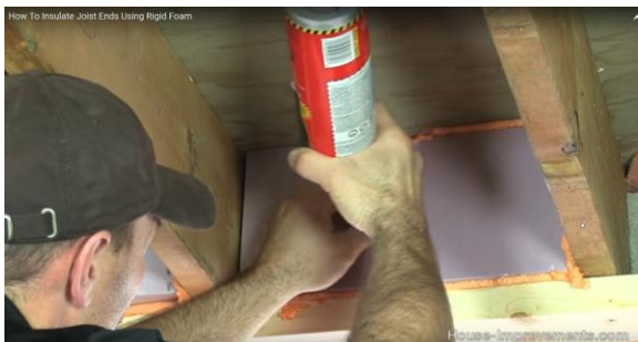
Bild 3 Ausschnitt aus einem Video zur Abdichtung von Balkenköpfen mit PUR-Bauschaum („ Bauschaum-Tutorial (2019) “)
