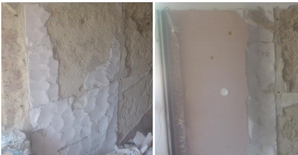
Bild 28 Abbruch Perliteplatte: einzelne Abscherflächen sind links gut sichtbar
