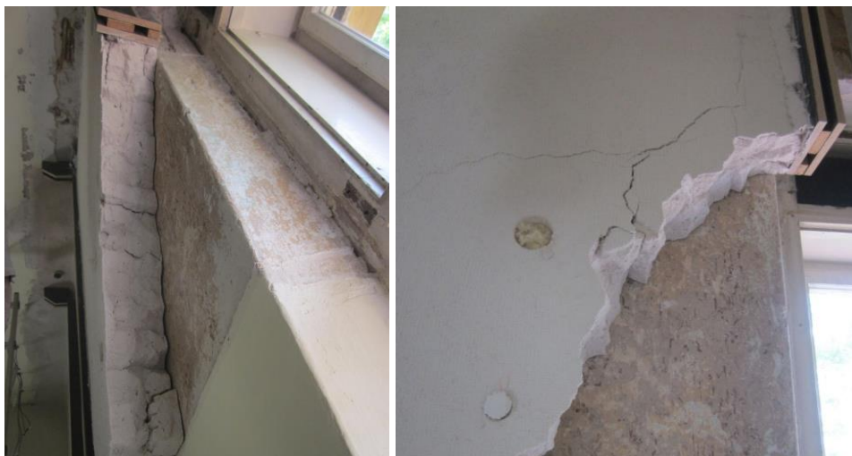
Bild 29 Abbruch Wärmedämmputz
