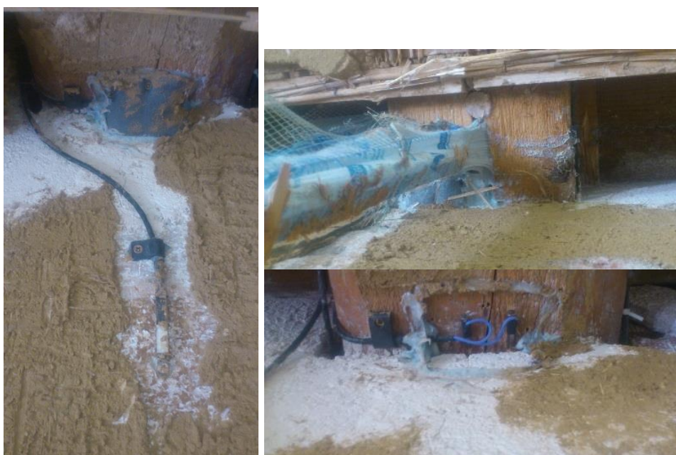
Bild 32 Sensoren nach Entfernen der Schilfdämmung an Auflager 6
