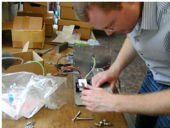
**Abbildung 46: Montage des Druckkopfes, Quelle: Eigene Darstellung.**
