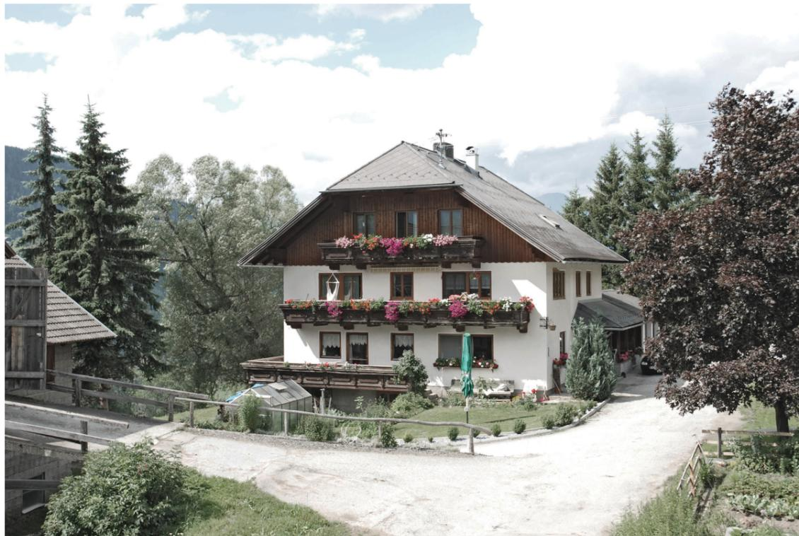
Abbildung 45: Die Fotografie zeigt das Bauernhaus vor der Ertüchtigung der Putzfassade im Jahre 2018. Im Zuge der Fassadenarbeiten sind an den Gebäudekanten verzahnte Eckstein aufgemalt worden und die Fenster bekamen graue Faschen.
