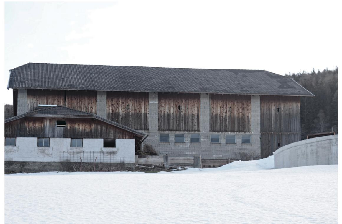
Abbildung 48: Der Schweinestall bekam einen neuen Dachstuhl und wurde später als Hühnerstall verwendet. Mittlerweile ist der Zubau aufgrund der schlechten Bausubstanz jedoch seit Jahren ungenutzt. Im rechten Bereich erkennt man die neu errichtete Jauchengrube aus Beton.
