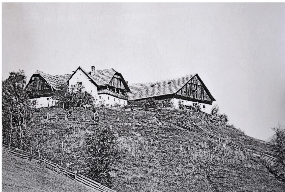
Abbildung 7: Das Bauernhaus in Lessach besitzt einen Dachstuhl mit Schopf, ein sogenanntes Krüppelwalmdach. Der dazugehörige Stall weist ein Satteldach auf. Beide Varianten finden sich in der traditionellen Lungauer Bauweise, wobei ersteres einen weitaus größeren Teil der Lungauer Dachlandschaft prägt.
