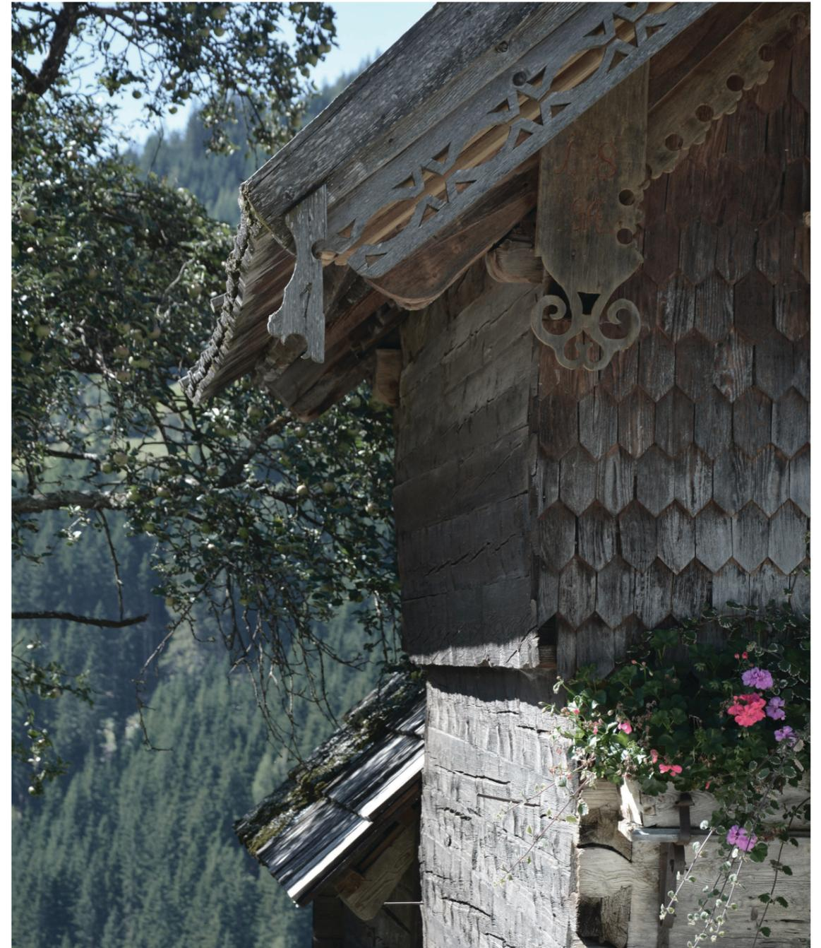
Abbildung 19: Der Sockel ist im Blockbau mit einem doppeltem Schwalbenschwanz über Eck verbunden. Die einzelnen Pfosten sind zusätzlich mit Holzdübeln gesichert. Darüber befindet sich wieder ein Blockbau, welcher auf der Hauptseite mit Schindeln verkleidet ist. Die Windläden sind aufwändig mit Ornamenten ausgestattet. Das Dach besteht aus einem Schindeldach in Dreifachdeckung.
