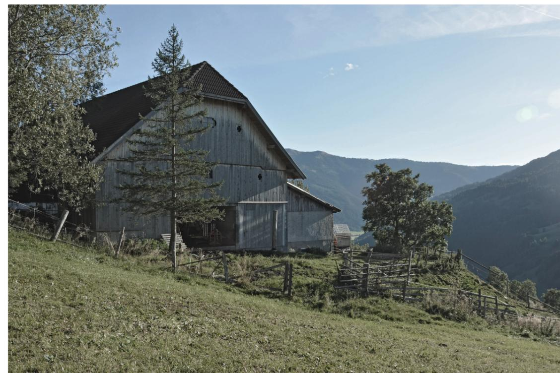
Abbildung 37: Die Kombination einer teilweisen Verbreiterung des Stalles und einer Verlängerung des Hauptgebäudes findet sich beim Boa (13). Im längsseitigen Zubau sind Stellplätze für landwirtschaftliche Fahrzeuge vorhanden. Die Verlängerung ist im Jahr 2009 als Überdachung des vorgelagerten Hochsilos aus einer Holzkonstruktion errichtet worden. Die Dachneigung und Dachform wurde übernommen und gestreckt.
