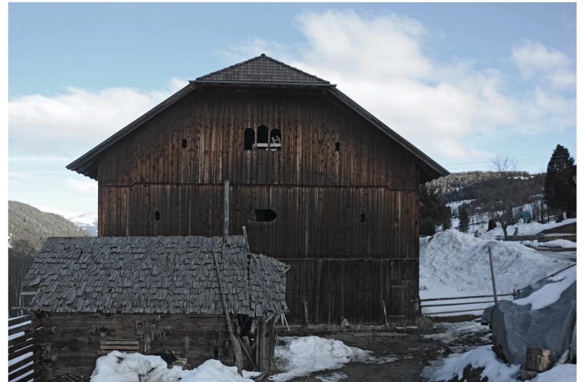
Abbildung 50: Das Dach der ungenutzten Mühle ist mittlerweile stark beschädigt und in die Jahre gekommen. Das alte Bauernhaus wurde aufgrund der Beschädigungen des Feuers an einer anderen Stelle neu errichtet.
