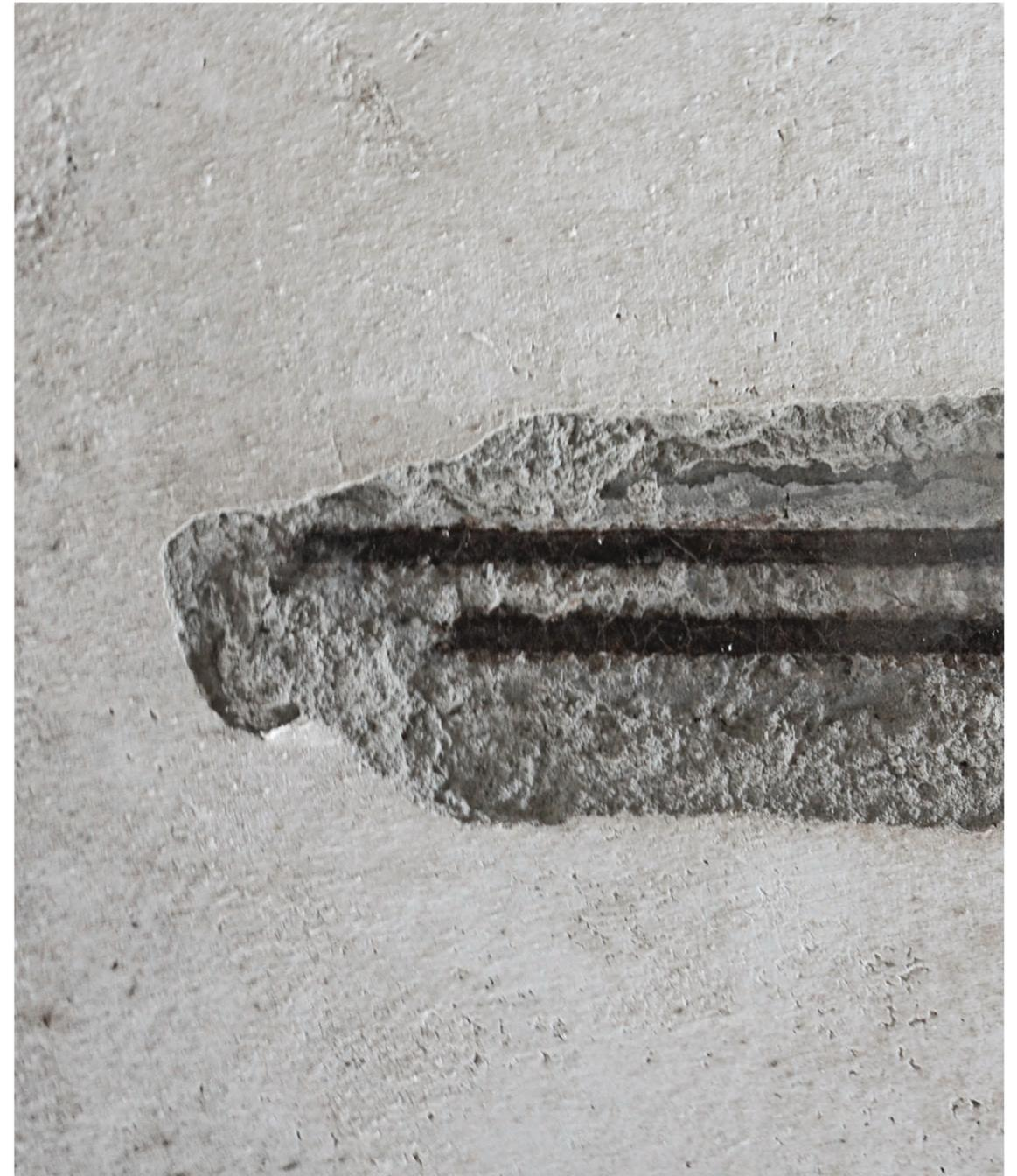
Abbildung 53: Der Saustall weist aufgrund der erhöhten Ammoniakbelastung durch den Schweinemist über die Jahre bauliche Mängel auf. Die zu geringe Überdeckung des Betons wurde porös und platzte ab. Die Bewehrungseisen kommen dadurch zum Vorschein und beginnen zu korrodieren. Die statische Tragfähigkeit der Decke ist nicht mehr gegeben und muss dadurch ersetzt werden.
