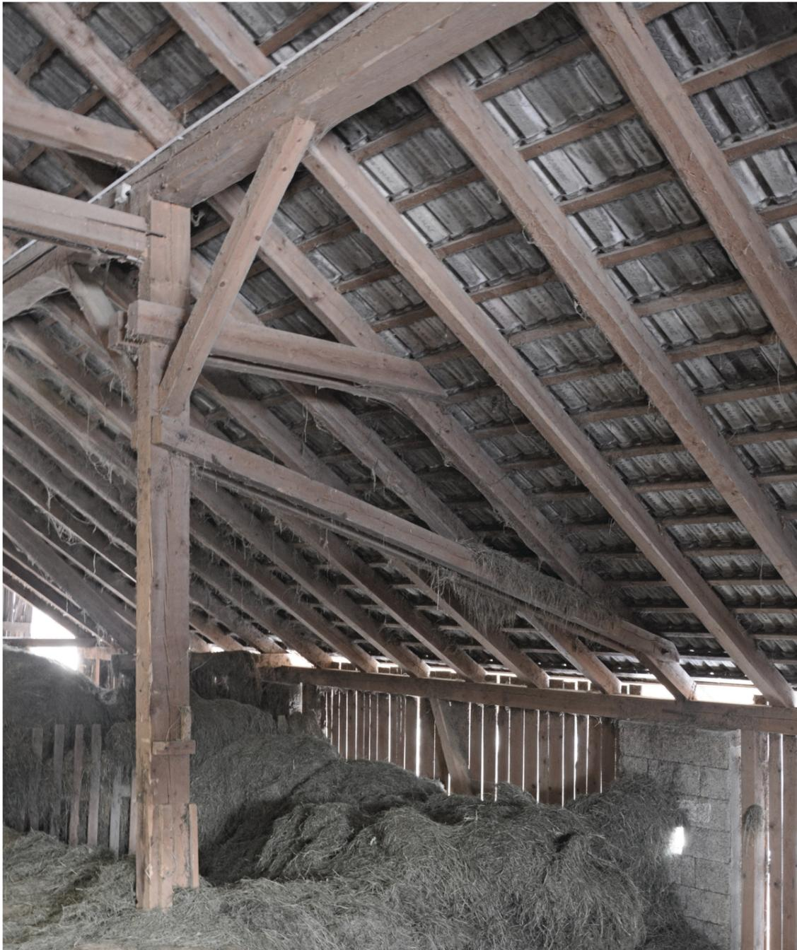
Abbildung 52: Die Holzkonstruktion und der Dachstuhl sind in ihrer Funktionalität noch gebrauchstauglich. Die bauliche Substanz ist gut erhalten und kann ohne Bedenken weiterverwendet werden. Der Heubergerraum ist mit einem Heukran gut bedienbar und statisch ausreichend dimensioniert.
