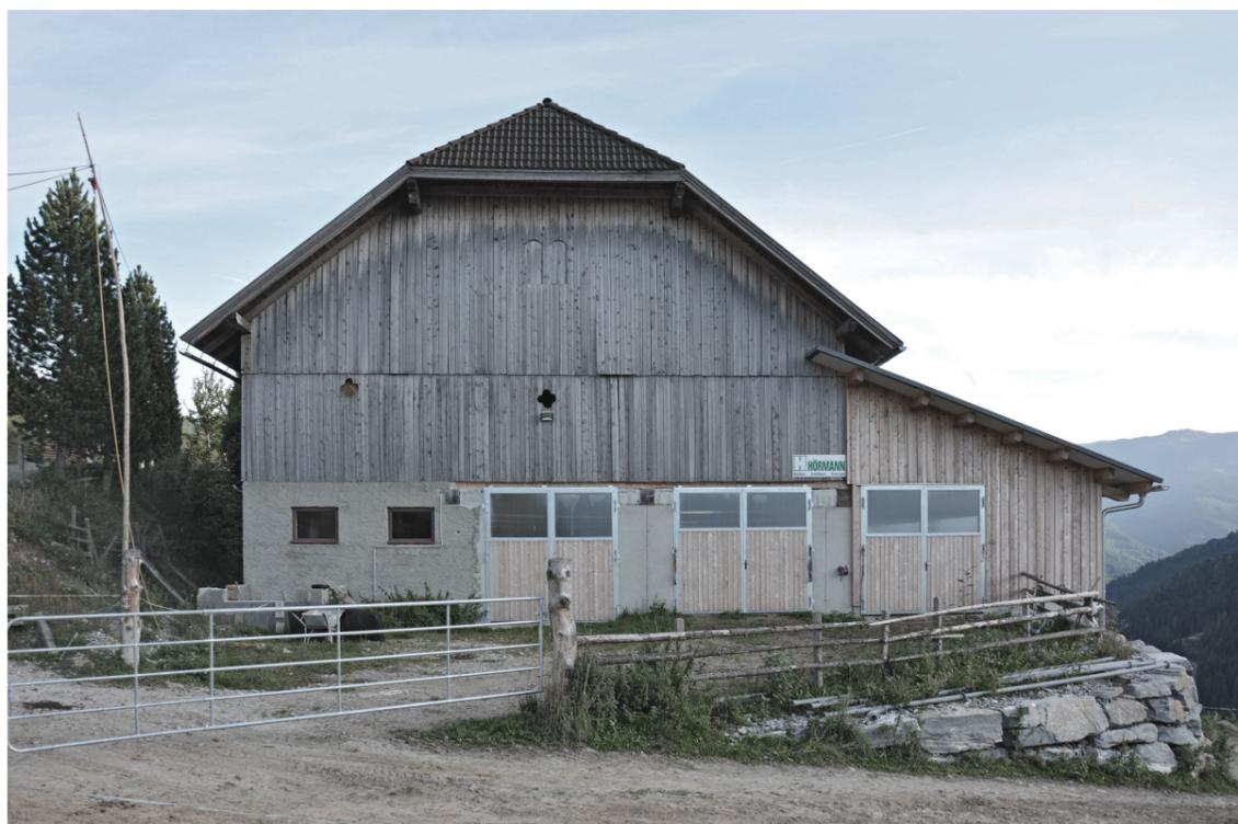
Abbildung 36: Beim Muhrer (2) wurde im Jahre 2017 der bestehende Stall aus dem Jahre 1947 im Erdgeschoss entkernt, die Bodenplatte entfernt und die historischen Fundamente unterfangen. Hangabwärts ergänzte die Baufirma den Bestand um einen hölzernen Zubau mit einem Pultdach. Unter dem neuen Holzbau befindet sich ein Güllekeller. Durch die zusätzliche Breite im Erdgeschoss konnte der Anbindestall in einen Laufstall umgebaut und der darüberliegende Heubergerraum weitergenutzt werden.
