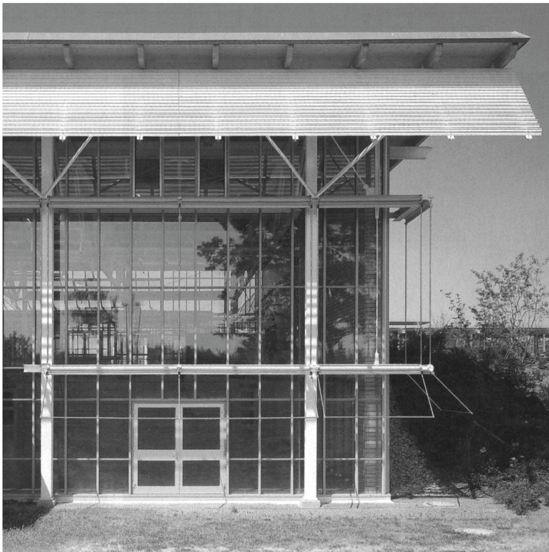
**Abb. 21:** Glasfassade mit externer Beschattungskonstruktion bei Sporthalle in Stuttgart
