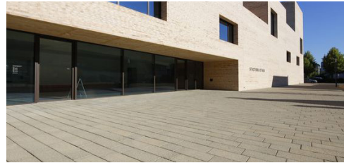
Abb.184 Stadtbibliothek Heidenheim, Deutschland
