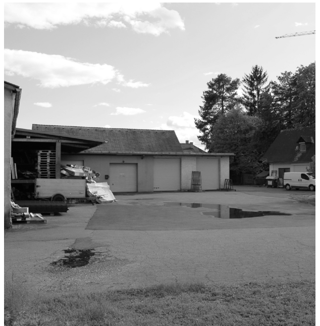
Abb.88 Bahnhofstraße Ansicht B
