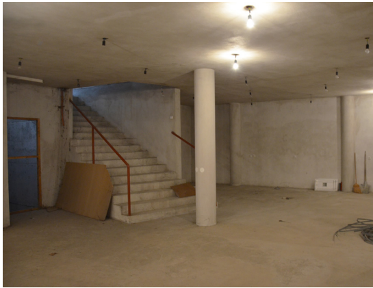
Abb. 34 Stiegenaufgang und Liftschacht -1.UG
