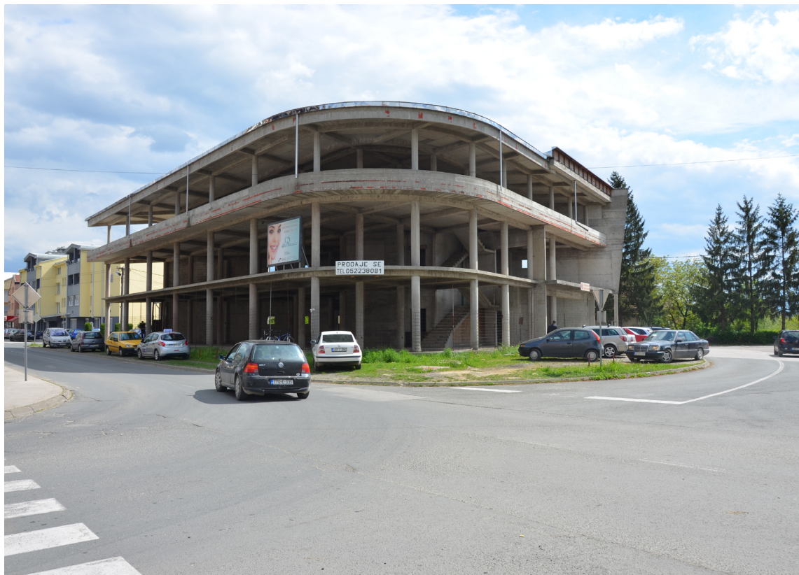
Abb. 31 Bestandsgebäude_Ansicht von Nordwesten
