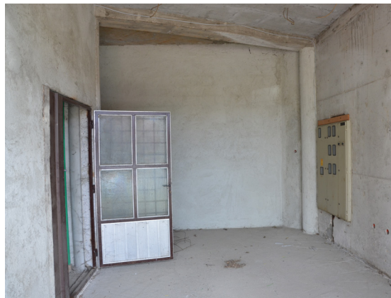
Abb. 42 EG Eingang zum Untergeschoß
