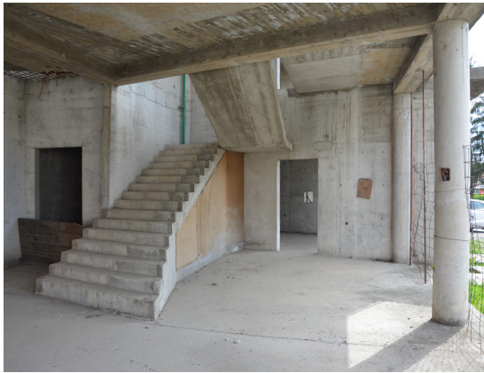
Abb. 39 Stiegenaufgang und Liftschacht EG
