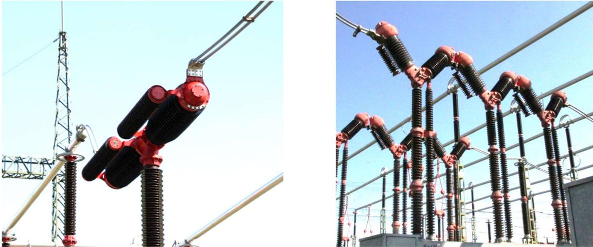
Abbildung 3-12: Leistungsschalter mit Steuerkapazitäten für die 400-kV-Spannungsebene
