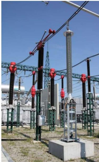
*Abbildung 5-3: Installierter ohmsch-kapazitiver 400-kV-Spannungsteiler in einer Hochspannungsanlage nahe eines Transformators*
