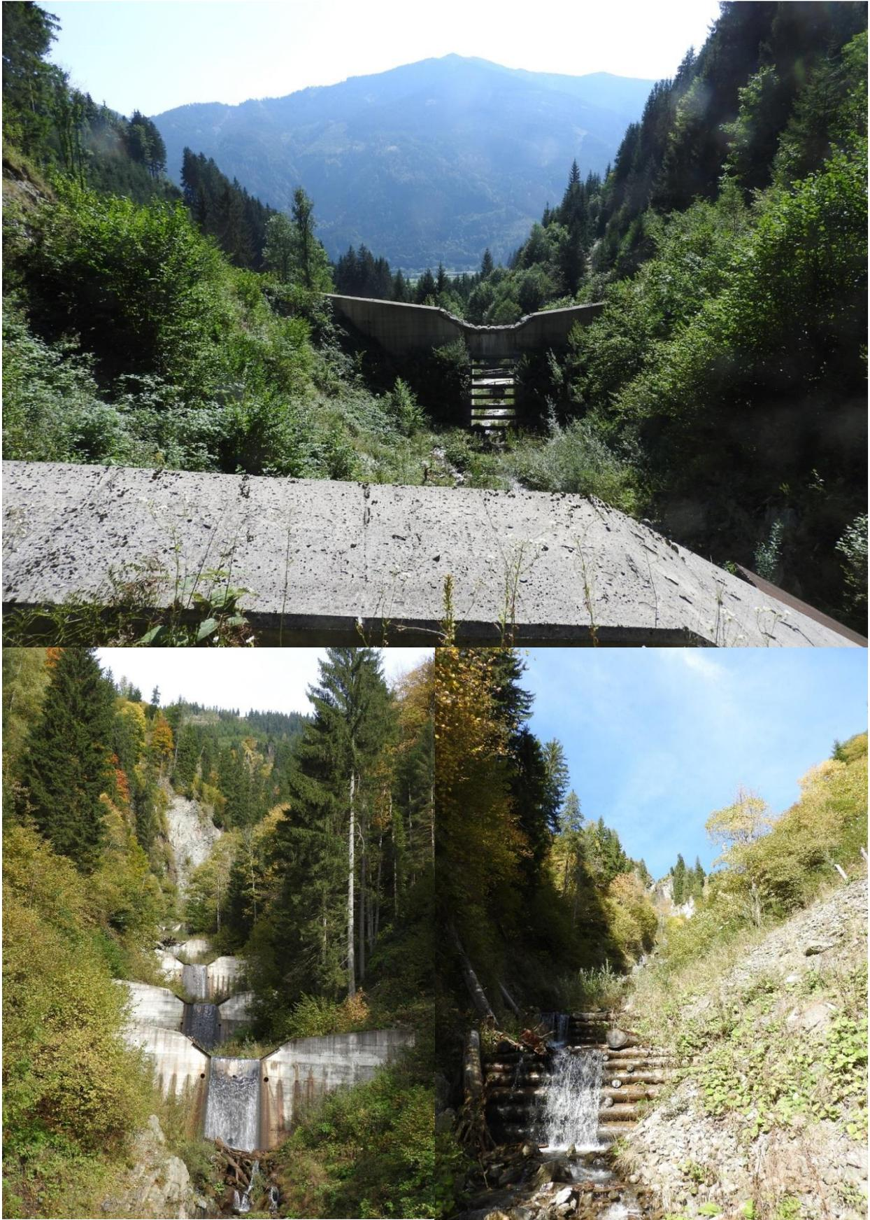
Abbildung 9: Überblick über Verbauungsmaßnahmen: oben Dosierwerk, li. Konsolidierungssperren, re. Rundholzsperrern
