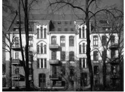
Abb.58: Alte Schule Karlshorst
