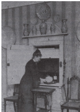
Abb.6: Speiseaufzug, Einküchenhaus Kopenhagen
