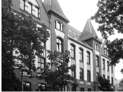
Abb.57: Alte Schule Karlshorst
