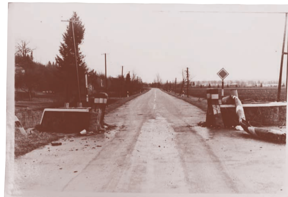
Abb. 53: Diese Fluchtversuchdokumentation aus 1969 zeigt die aktuelle Lage der alten Grenzstraße. Diese war noch schnurgerade und nicht asphaltiert.
