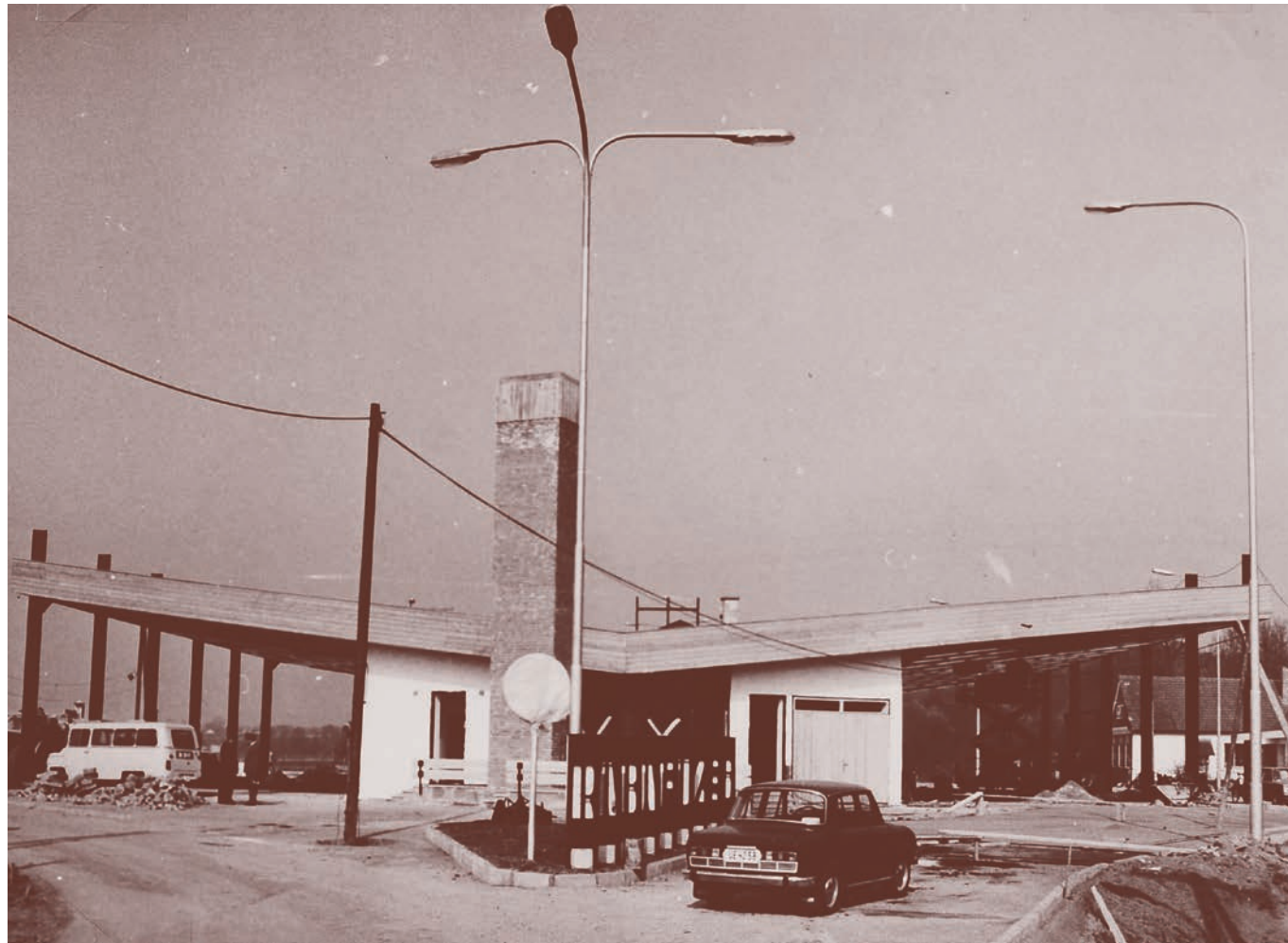
Abb. 59: Mit den Titel „Bau des neuen Grenzübergangs“ würde dieses Foto gleich nach der Fertigstellung 1973 angefertigt.
