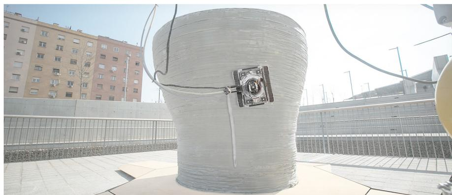
Minibuilders beschäftigt sich damit, dass die Produktion von großformatigen Bauteilen durch 3DCP, mit bis jetzt üblichen Methoden meist durch den maximalen Druckbereich der Anlage limitiert ist. Diesen Bereich versucht das Projekt zu maximieren, indem drei Roboter entwickelt wurden, welche sich autonom auf der von ihnen zu druckenden Struktur bewegen können und das Druckmaterial verteilen.<sup>17</sup>
