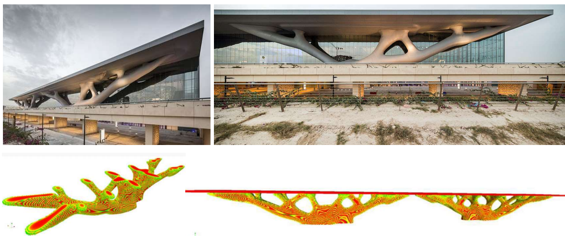
Abb. 15 Qatar National Convention Centre im gebauten Zustand (Oben) [32] und das Simulationsmodell (Unten) [33]
