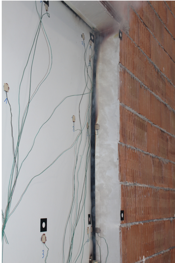
Abbildung 34: Rauchgasaustritt an der oberen rechten Kante bei der Ziegelwand mit der Tür links
