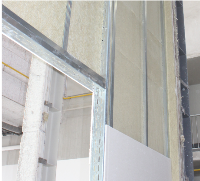
Abbildung 3: Aufbau der Leichtbauwand
