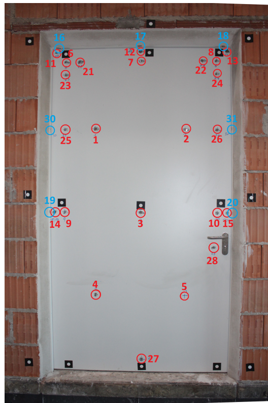
Abbildung 24: Anordnung der Messstellen an der feuerabgewandten Türseite
