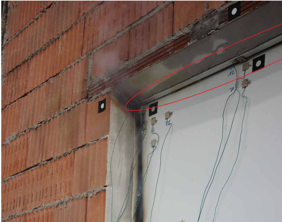
Abbildung 41: Auftretende Durchbiegung an der Oberkante der Türe bei der Ziegelwand mit der Tür in mittlerer Position
