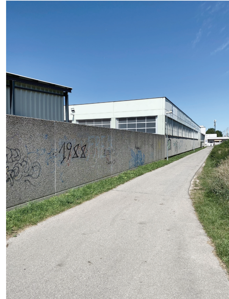
Abbildung 37: hohe Mauern erzeugen Angsträume
