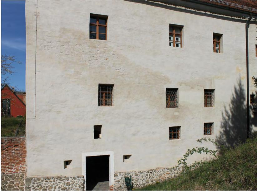
**Abb.68:** Südfassade mit großflächigem Putzschaden
