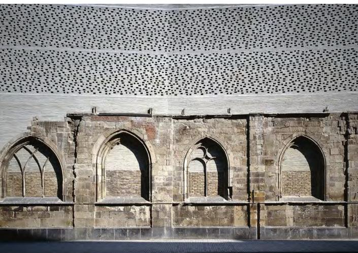
**Abb.115:** Die neuen Ziegel fügen sich im Verband an die Überreste der alten Mauern
