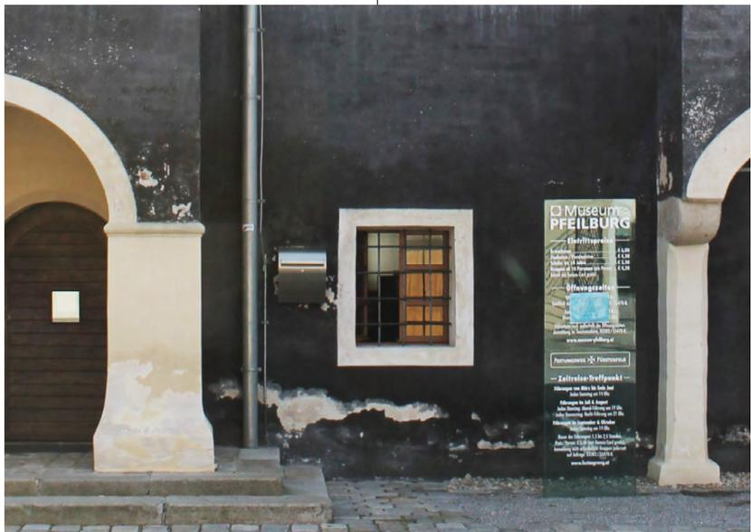
Abb.67: Putzschäden an der Hoffassade (nahe Renaissanceerker und Haupteingang)
