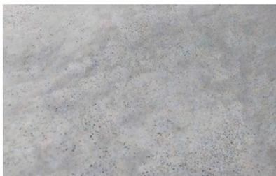
**Abb.169:** Zementestrich, nachebearbeitet, angeschliffen, versiegelt
