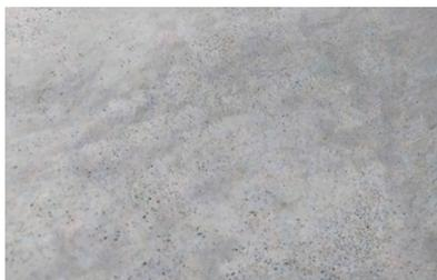
Abb.173: Zementestrich, nachbearbeitet, angeschliffen, versiegelt
