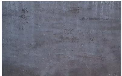
**Abb.157:** Schwarz-Grauer Farbputz an den Schauffassaden, verwittert
