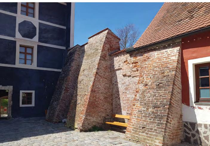
Abb.48: Stützmauer des benachbarten Erdwalles der historischen Wehranlagen
