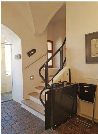
**Abb.102:** Der Treppenlift, der über die Treppe vom 1. in das 2. Obergeschoß führt
