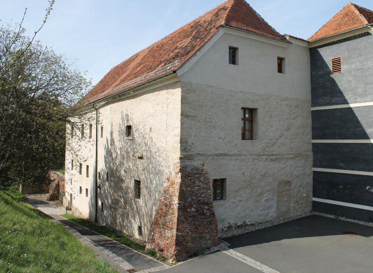
**Abb.49:** Süd-Ost-Ecke des gotischen Wehrturmes mit Eckpfeilerverstärkung aus Ziegelmauerwerk und Buckelquadern
