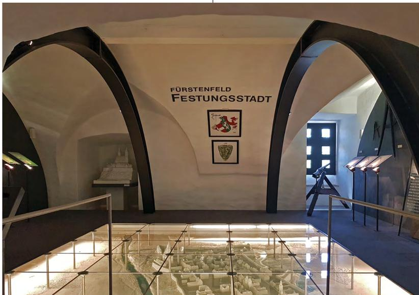
**Abb.198:** Rezente Stahlbögen unterstützen das Gewölbe des gotischen Turmes
