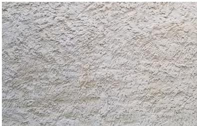
**Abb.156:** Grober Kalkputz an der Hinterseite des gotischen Turmes
