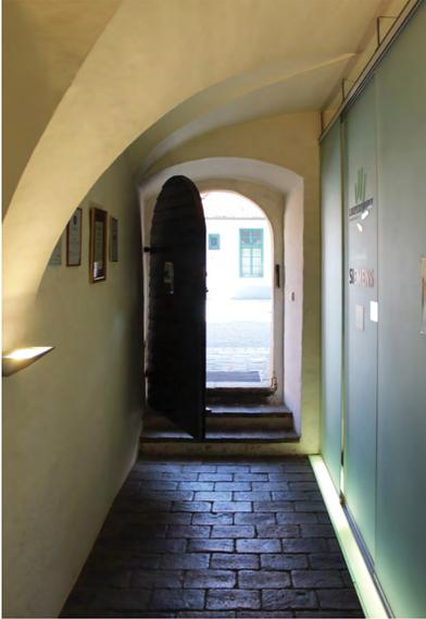
Abb.75: Die Eingangsstufen zum Ticketshop und WC sind nicht barrierefrei
