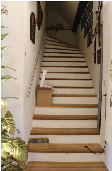
**Abb.101:** Dachbodentreppe: Die Lage unter dem Kniestock des Dachstuhls vermindert die lichte Durchgangshöhe sehr stark
