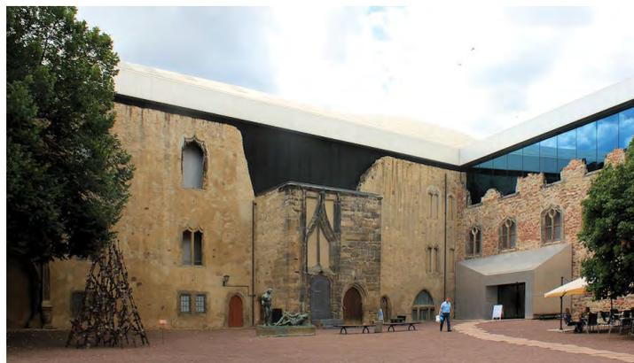
Abb.136: Dunkles Material bildet die Trennfuge zum Bestand
