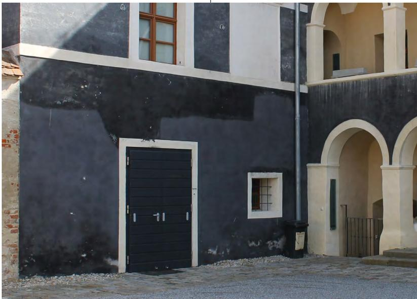
**Abb.69:** Putzschäden an der Hofseite des Barockzubaus
