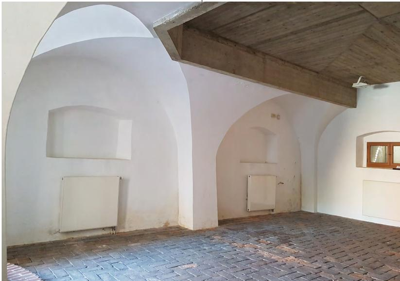
**Abb.188:** Kleinveranstaltungsraum mit Blick auf die rezente Stahlbetondecke (Ersatz der der Spiegeldecke in der Mitte)
