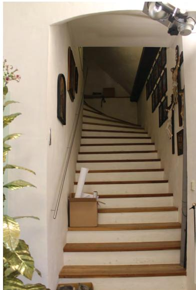
Abb.220 Dachbodentreppe mit verminderter Durchgangshöhe
