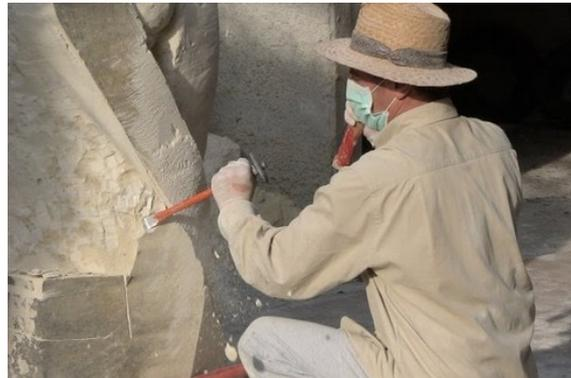
Abb. 8: Steinmetz beim Behauen eines Werkstückes
