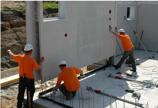
Abb. 7: Arbeiter beim Versetzen einer vorgefertigten Betonwand
