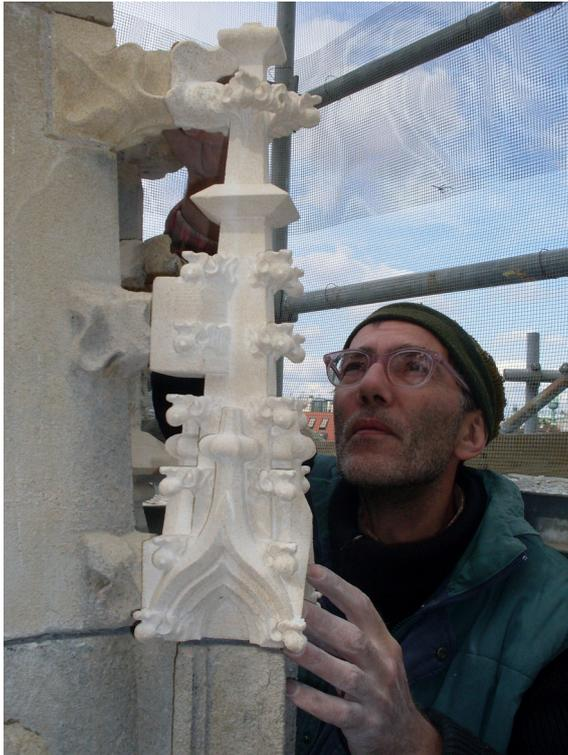
Abb. 16: Einrichten einer neuen Fiale durch die Bauhütte des Stephansdomes in Wien
