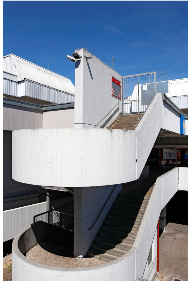
38 | Verschlüsselter Zugang zum Dachgeschoss
