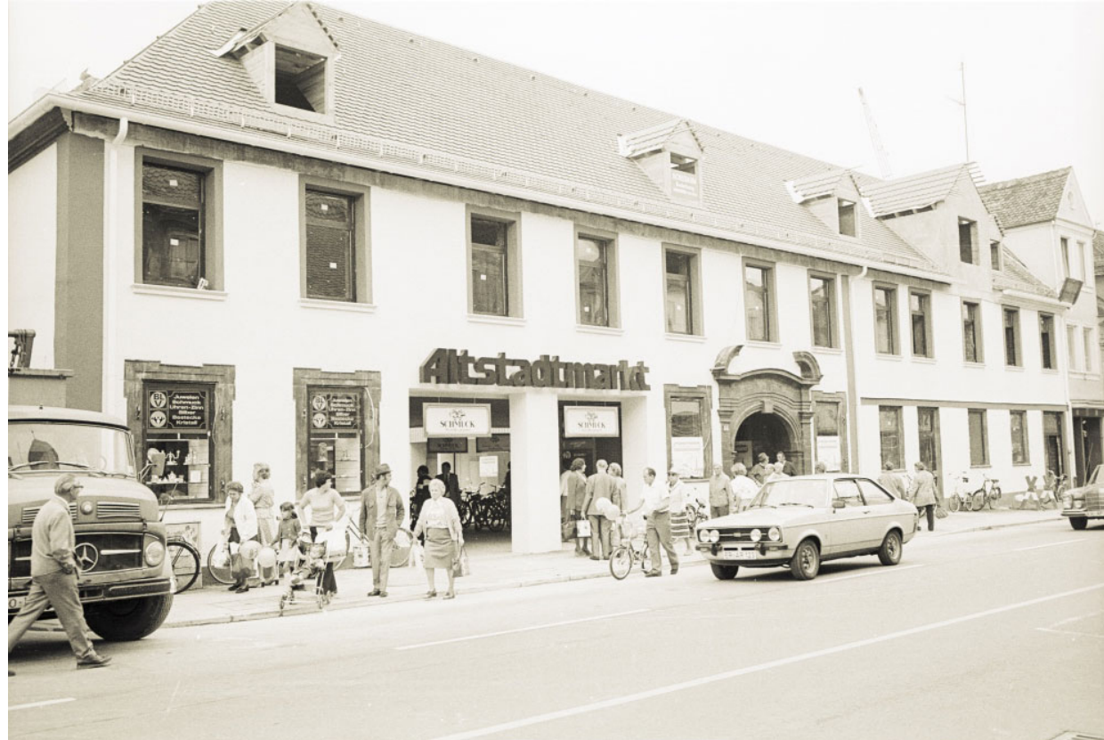
12 | Die historische Fassade wurde wieder neu aufgebaut und neben dem alten Portal wurde ein zweiter Eingang geschaffen. Foto aus dem Jahr 1976
