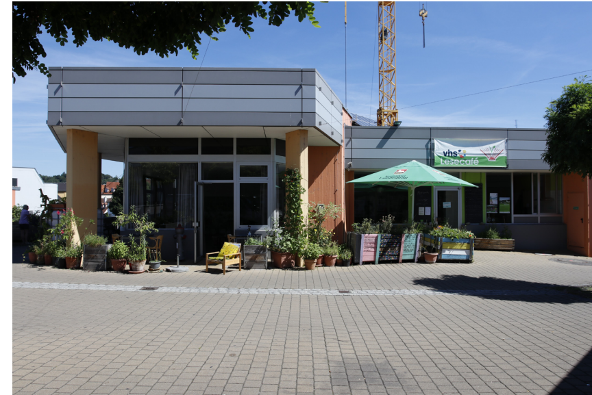
24 | Lesecafé im „Kopfbau“ der nördlichen Passage
