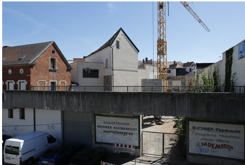
39 | Lücke in der westl. Stadtmauerstraße
