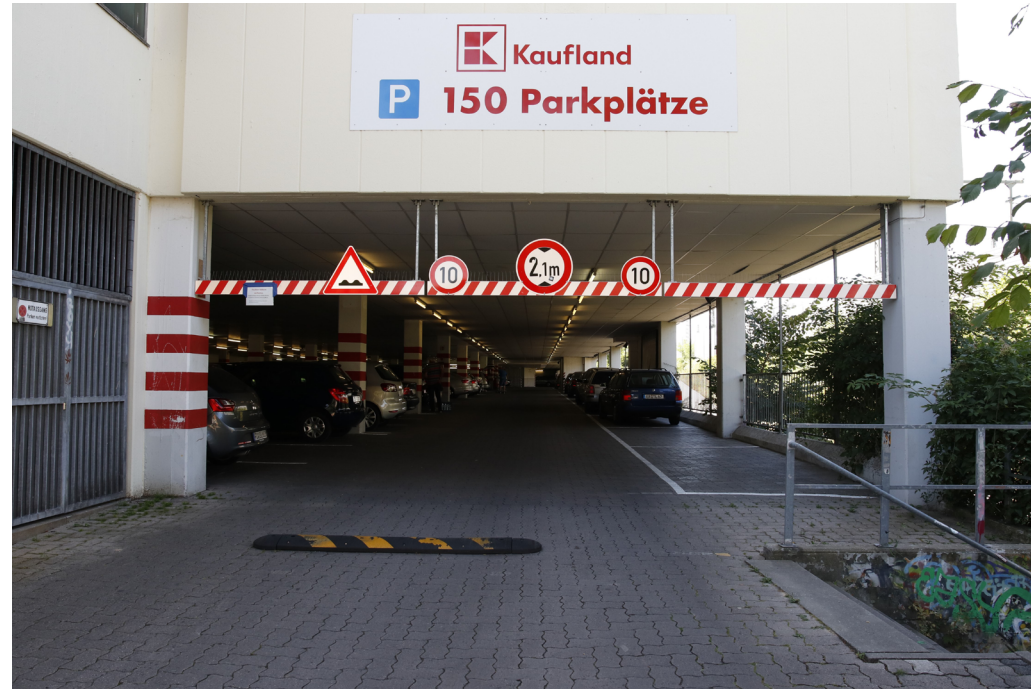
41 | Bestehende Tiefgarage mit 150 Stellplätzen und weiteren davor.
