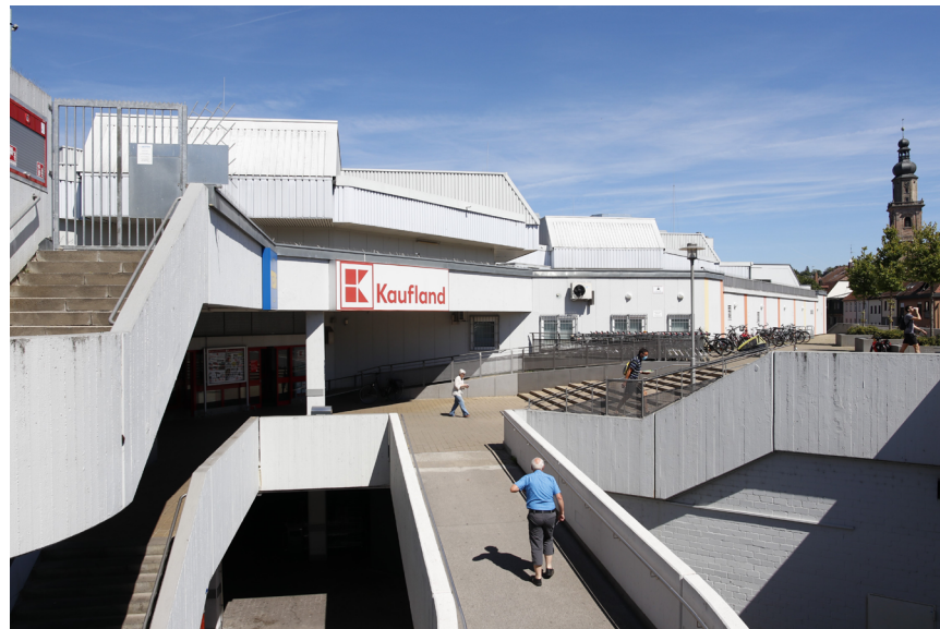
27 | versperrter Dachzugang, Rampe zur Tiefgarage
