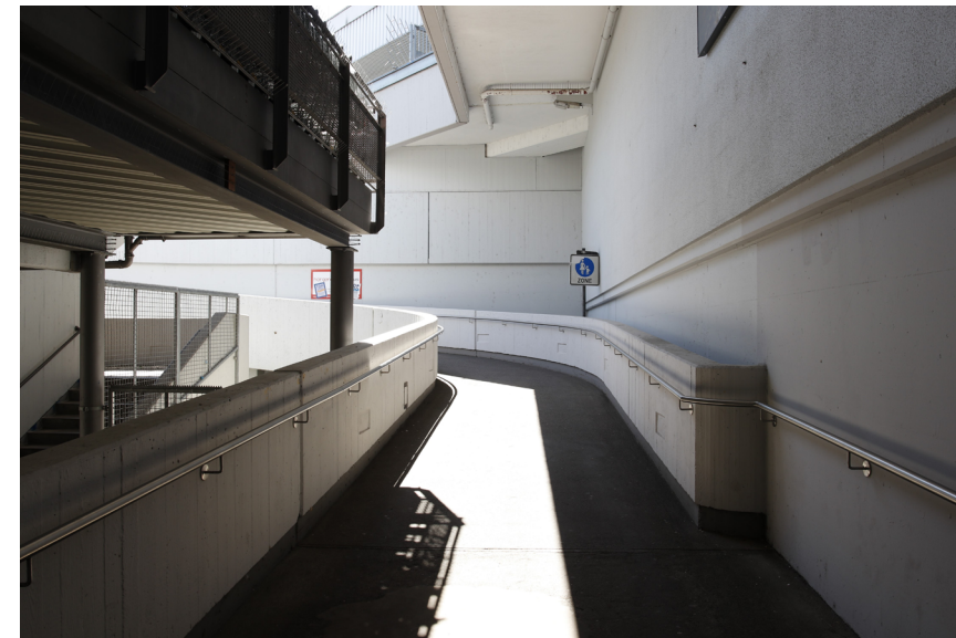
29 | Rampe aus der Tiefgarage
