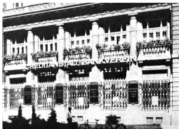
Abb. 9: ehem. Steiermärkische Escompte Bank, 1909–10
