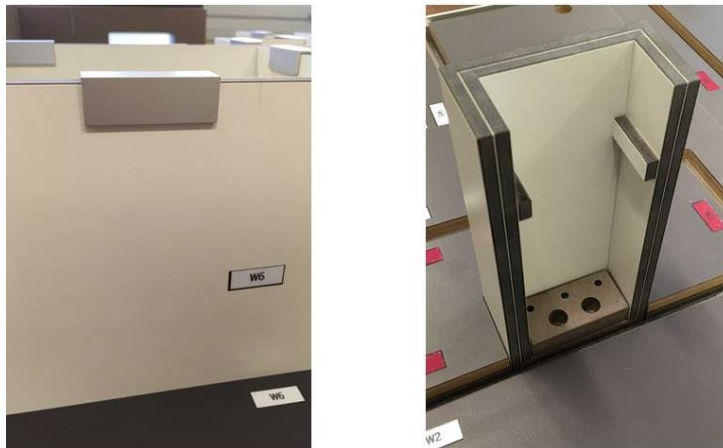
Abbildung 17: Trockenbau Innenwand und Steigschacht
