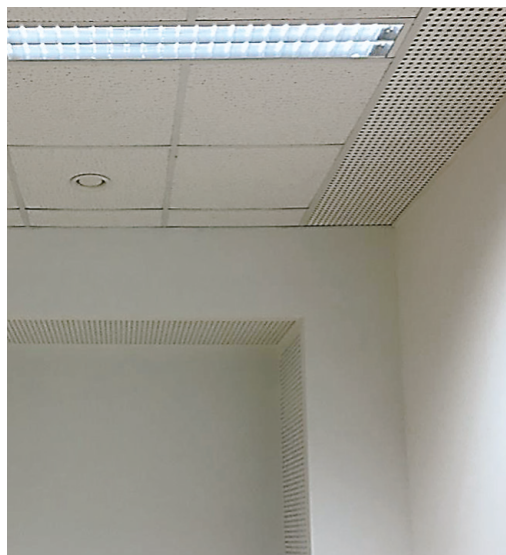
Abbildung 3.3: Kantenabsorber im Hörsaal i15 der TU Graz. Zu sehen sind Koffer aus Gipskartonplatten, einseitig gelocht und mit Mineralwolle gefüllt. An der Decke wurde der Platz unter einem bereits installierten Abhang mit Deckenfliesen genutzt, um einen 42 cm breiten Randstreifen Mineralwolle einzubringen.
