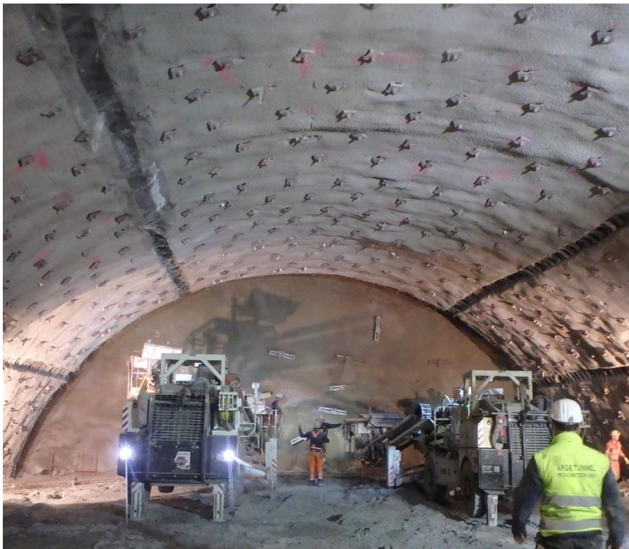
Abbildung 11: Ausbau der Längskaverne nach dem Ausbruch der Kalotte (Foto: ÖBA SBT 2.1).
