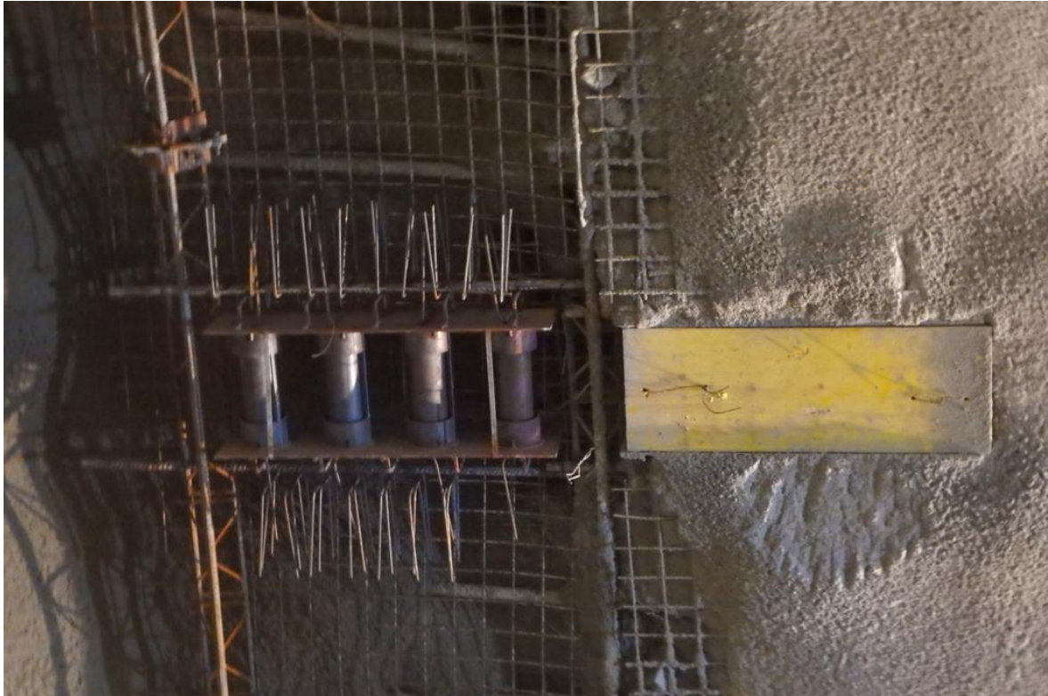
Abbildung 14: Stauchelemente im eingebauten Zustand, 4 Stauchrohre, mit zwei unterschiedlichen Längen (Foto: ÖBA SBT 2.1).
