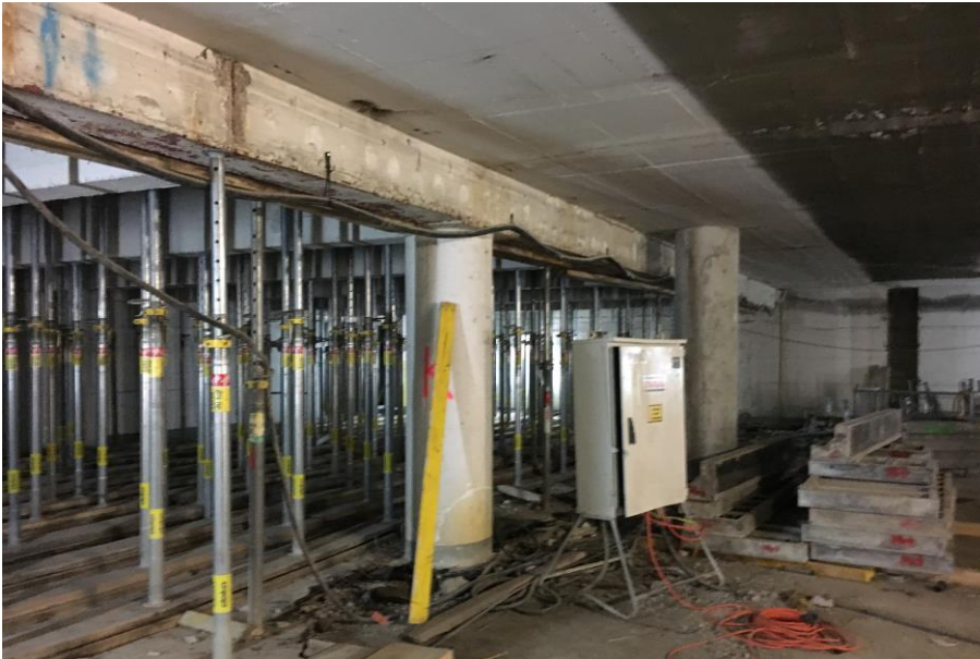
Abbildung 3-10 - Zusätzliche Unterstellung Bestand 1.UG – BVH2 130
