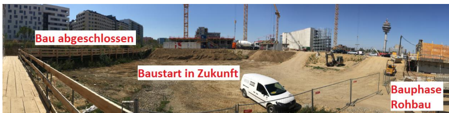
Abbildung 3-31 - Baugelände Hauptbahnhof - verschiedene Phasen der Bauvorhaben 155
