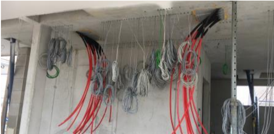
Abbildung 3-9 - Betonkernaktivierung (rot) – BVH2 129
