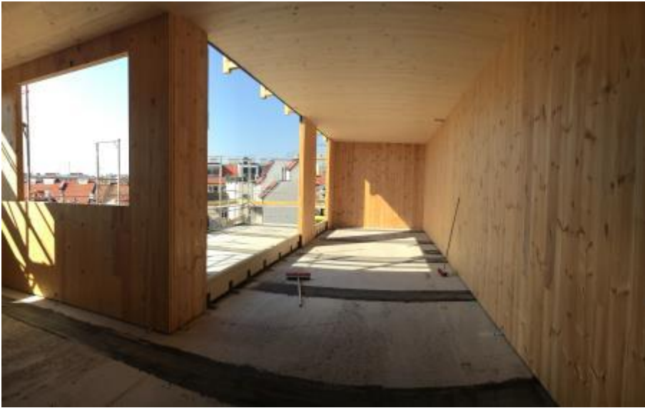
Abbildung 3-21 - Decken- und Wandelemente in Vollholzbauweise – BVH5 142
