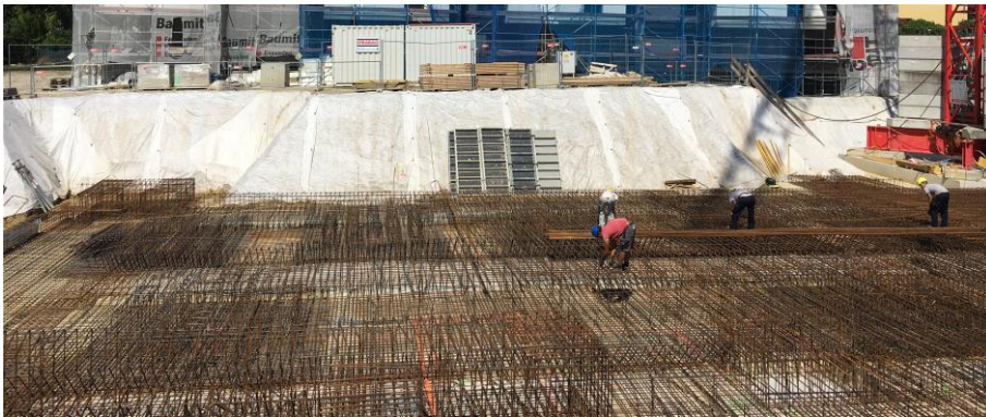
Abbildung 3-28 - Baugrubensicherung mittels Böschung – BVH8 150
