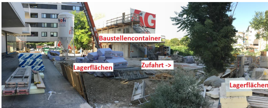
Abbildung 3-51 - Lagerflächen, Anlieferflächen und Baustellencontainer – BVH16 194
