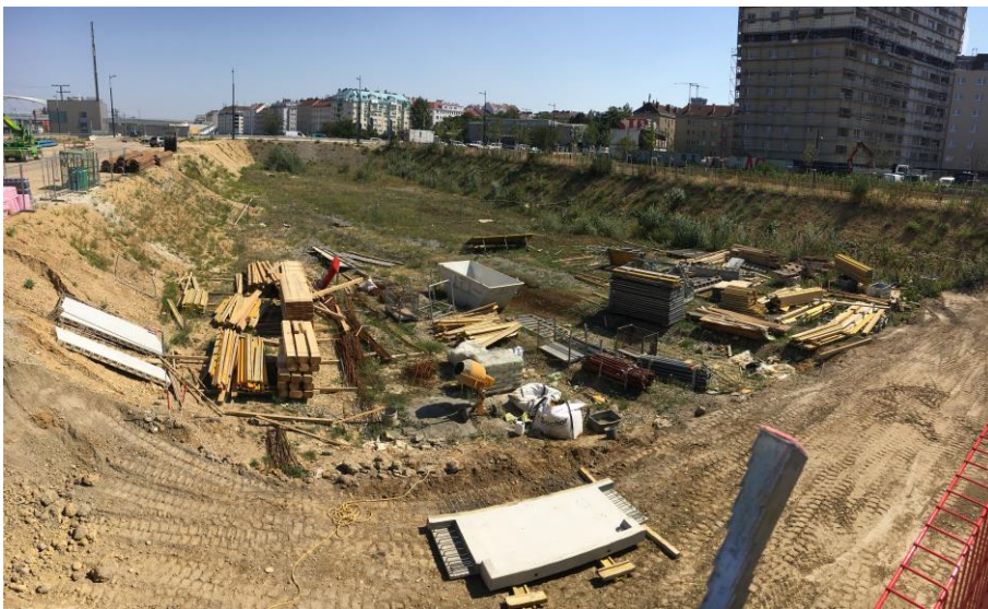
Abbildung 3-29 - Lagerung von Material am Nachbarbauplatz – BVH9 152
