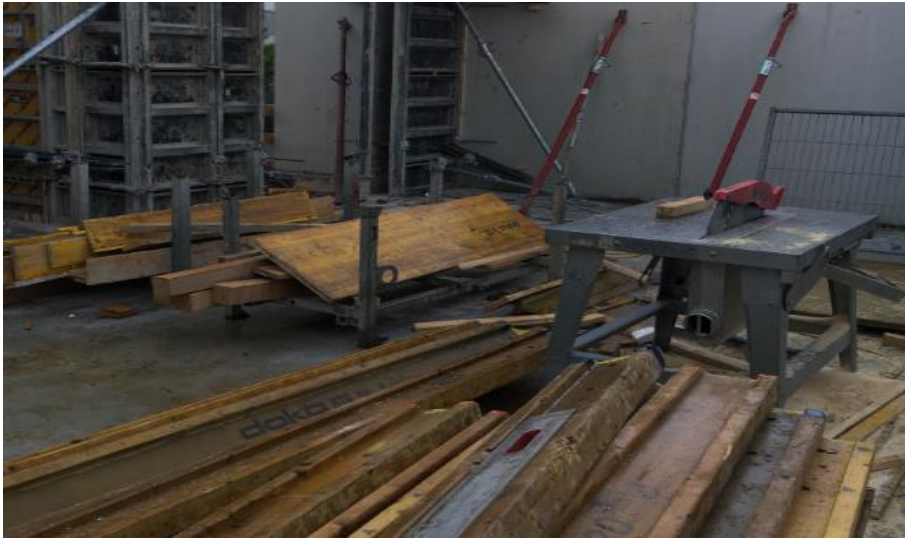
Abbildung 3-54 - Zwischenlagerung des Schalungsmaterials auf einer Geschossdecke – BVH17 201
