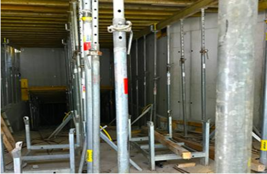
Abbildung 3-53 - Unterstützung der Kellerdecke – BVH17 199
