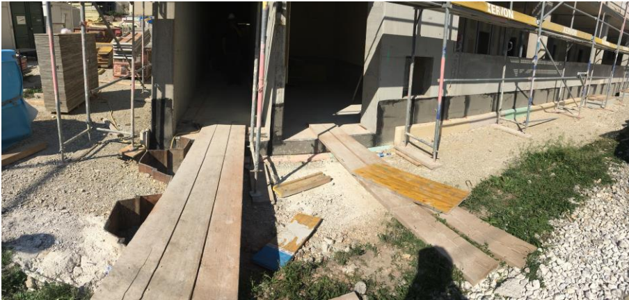
Abbildung 3-19 - Spundwände zur Sicherung der Baugrube des Folgeprojektes – BVH5
