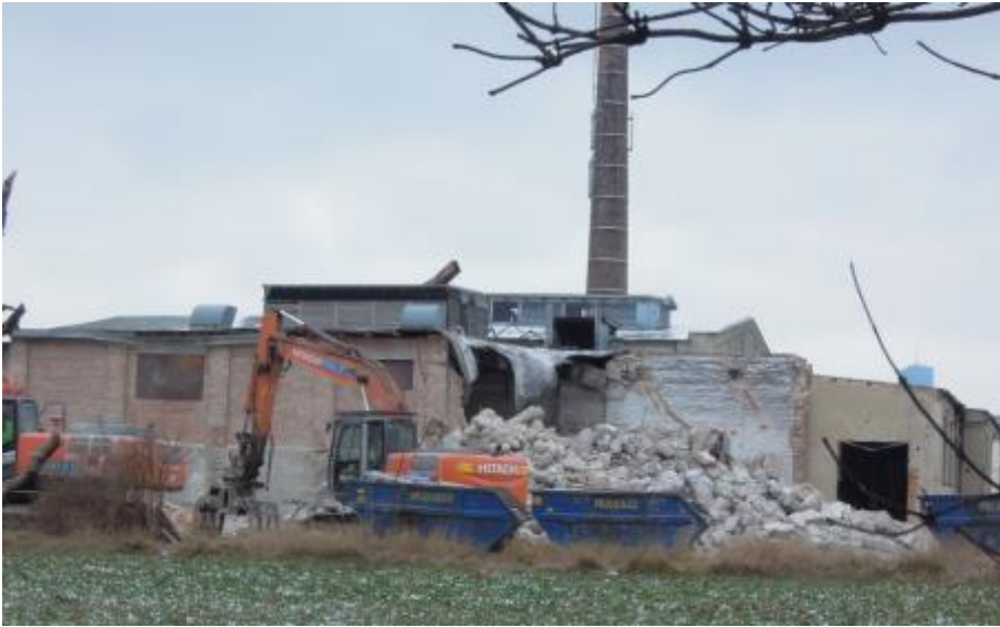
Abbildung 3-37 – Abbrucharbeiten Bestand – BVH13 168
