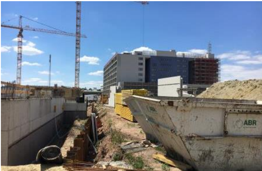
Abbildung 3-14 - Baugrubensicherung Bauplatz 5 mittels Spundwand – BVH4 135
