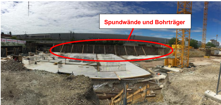
Abbildung 3-23 - Baugrubensicherung mittels Spundwänden und Bohrträgern – BVH6 144
