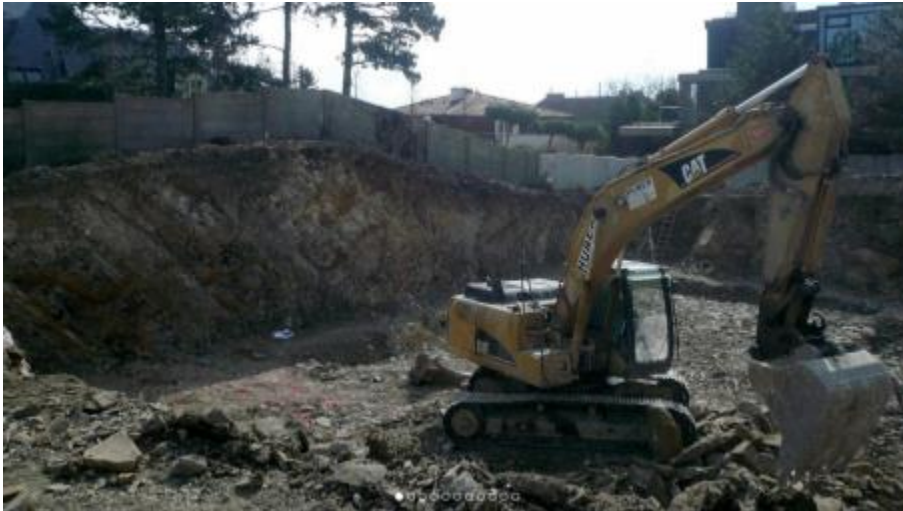
Abbildung 3-33 - Erstellung der Baugrube in Bodenklasse – BVH12 159
