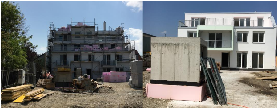
Abbildung 3-4 - Vergleich Rohbauphase und Ausbauphase – BVH1 121
