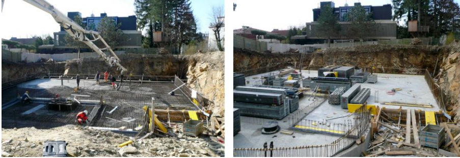
Abbildung 3-35 - Herstellung der Bodenplatte – BVH12 164
