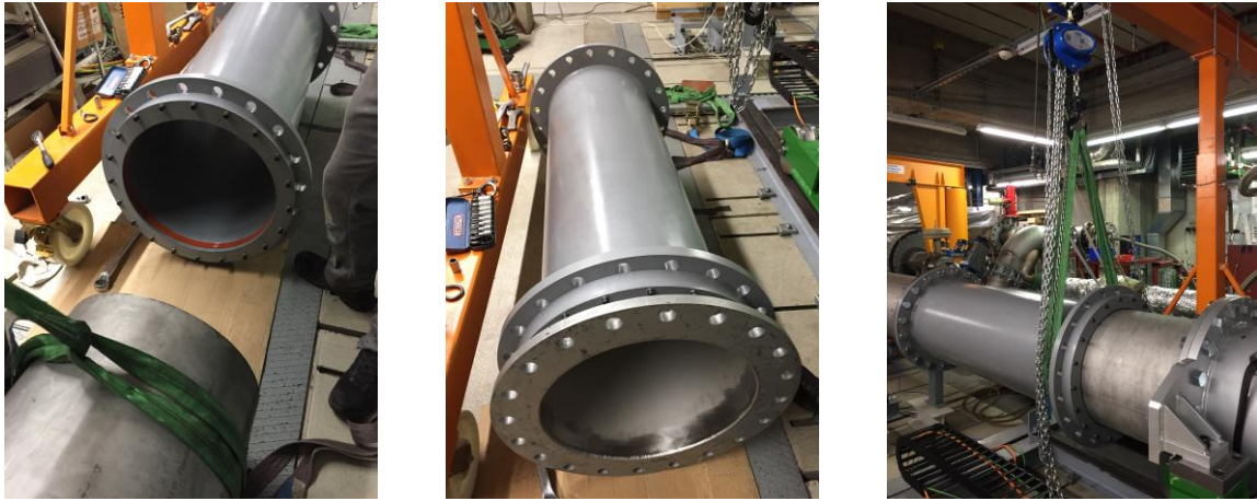
Abbildung 3.24: Fotoaufnahmen von den Arbeitsschritten der Verbindung des Diffusors mit dem Abluftrohr.
