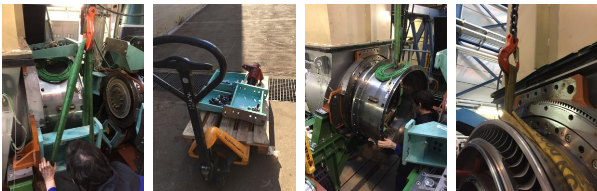
Abbildung 3.31: Demontage der Bwd-Beams und Bwd-Traversiermotor (links), vom Aft Outer Casing (Mitte rechts) sowie vom Deswirler (rechts) beim TTTF-Prüfstand.
