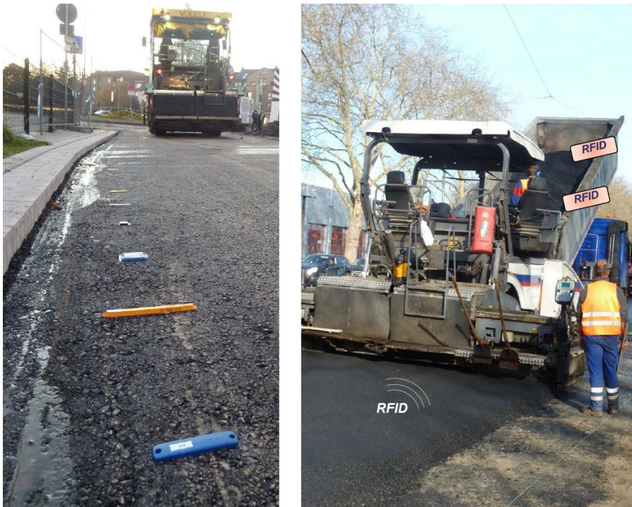
Abbildung 2-25: Verwendung von RFID-Tag bei Asphaltierungsarbeiten 116
