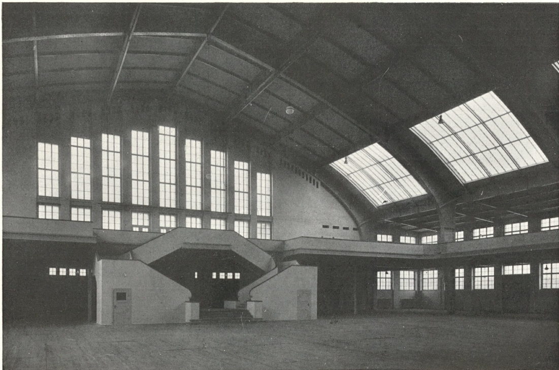
Bild 71. Neue Halle, Ausgang zur Galerie
