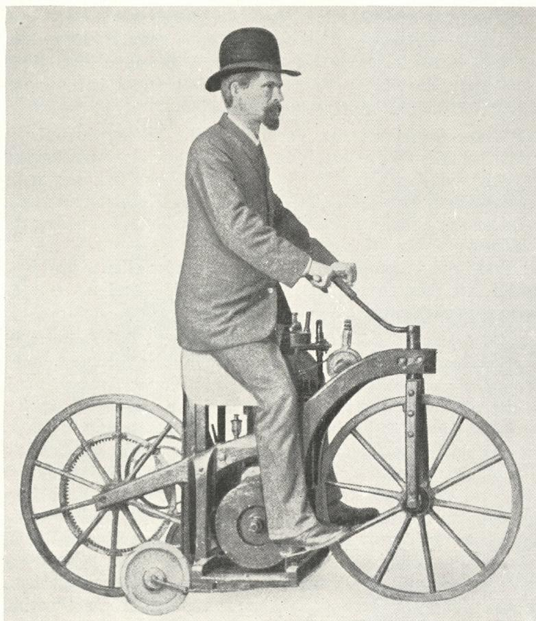
Bild 3. Maybach mit dem 1. Daimler-Motorzweirad 1886
