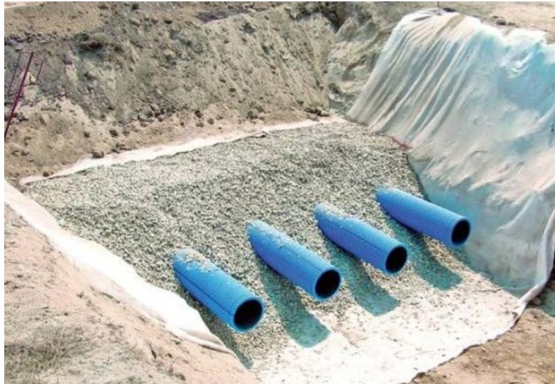
Abbildung 43: Ausführung Rohr-Rigolenversickerung
