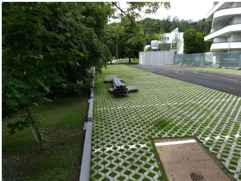
Abbildung 38: Rasengittersteine mit Muldenversickerung in der Green City Graz [58]
