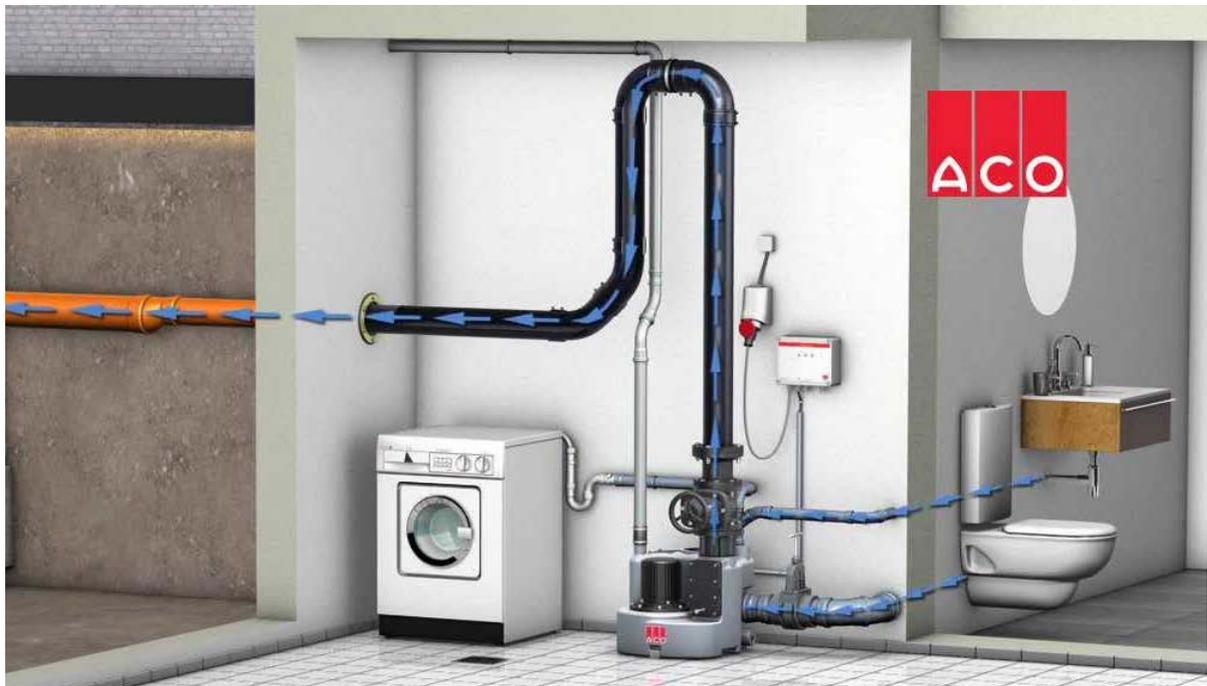
Abbildung 52: Hebeanlage für fäkalienhaltiges Abwasser
