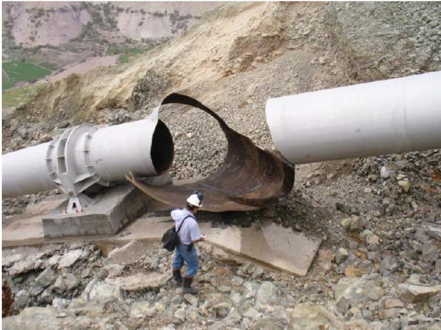
**Abb. 3.1:** Geborstene Druckrohrleitung durch einen Druckstoß [13]
