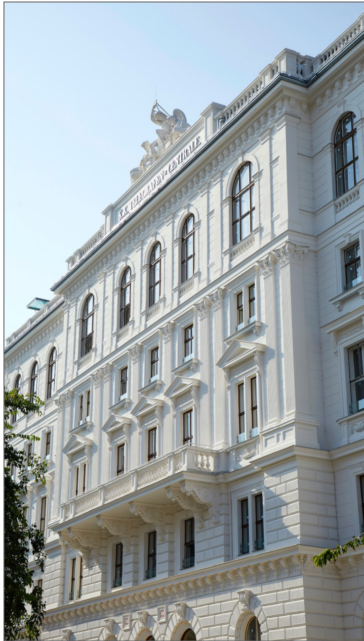
Abb. VIII-7 Fassade nach Fertigstellung / Foto Melbinger
