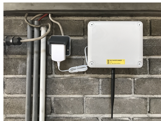
(b) Montage an der Wand
