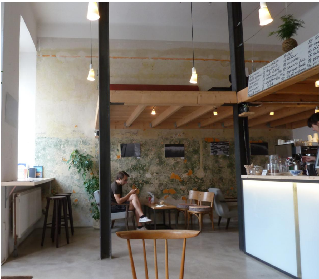
Abbildung 176: M. Klaura: Durch Stahl-Holzkonstruktion eingezogene neue –Galerie in hohem Raum eines Gründerzeitgebäudes, Prag, 2017, Bildsammlung Michael Klaura
