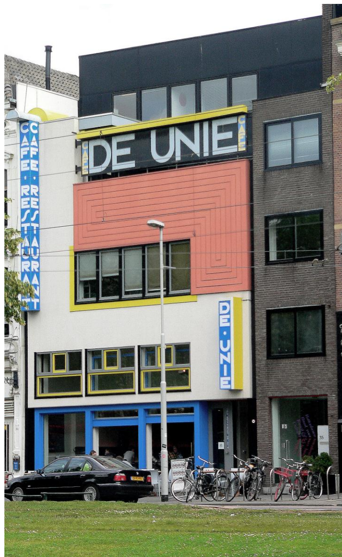
Abbildung 91: F.unbk.: Wieder aufgebaute Fassade des Café de Unie, Rotterdam, 21. Juni 2009, Fotografie, freie Lizenz
