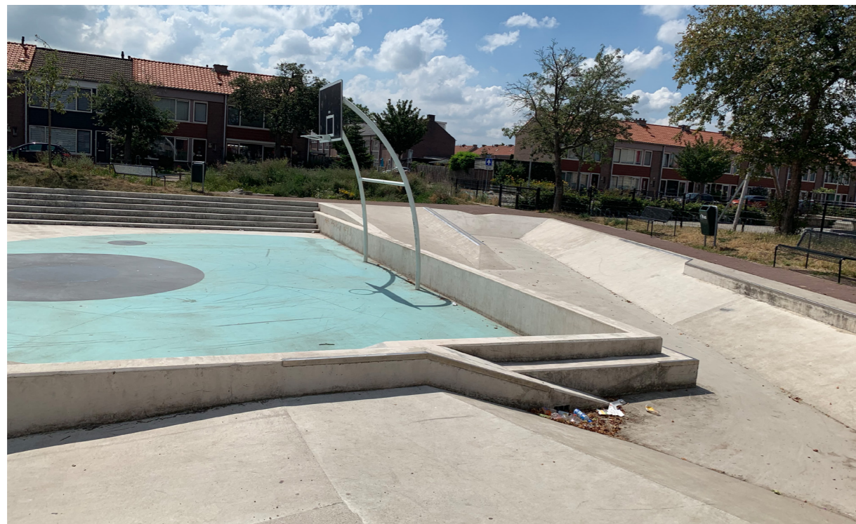
Abb. 44. Waterplein in Tiel Problemzonen
